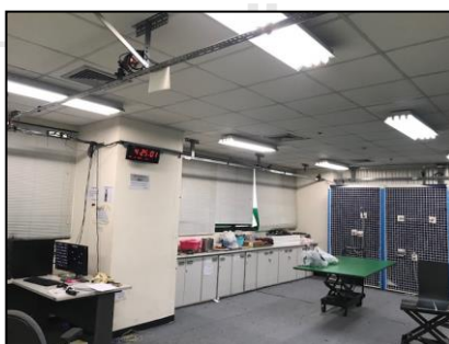
ภาพที่ 3. 27 พื้นที่ทำการทดลอง ที่มีการติดตั้งระบบเรียบร้อยแล้ว
