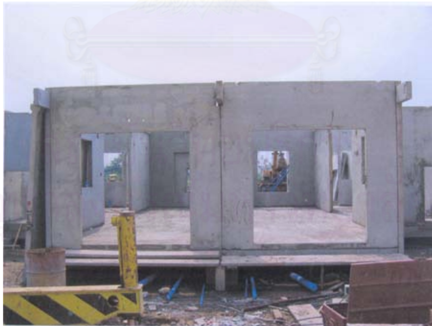
รูปที่ 5-16 แสดงงานติดตั้งพื้นชั้นล่าง
