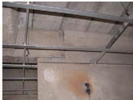
รูปที่ 5-29 งานทำฝ้าเพดานภายใน
