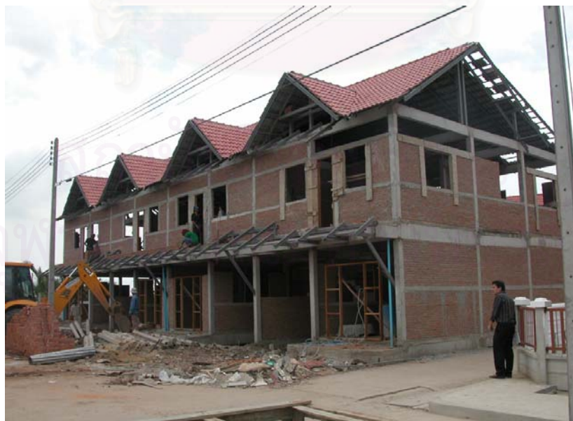
รูปที่ 5-9 แสดงงานก่อฉาบผนัง
