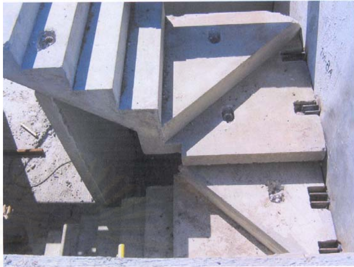
รูปที่ 5-17 แสดงการติดตั้งบันได
