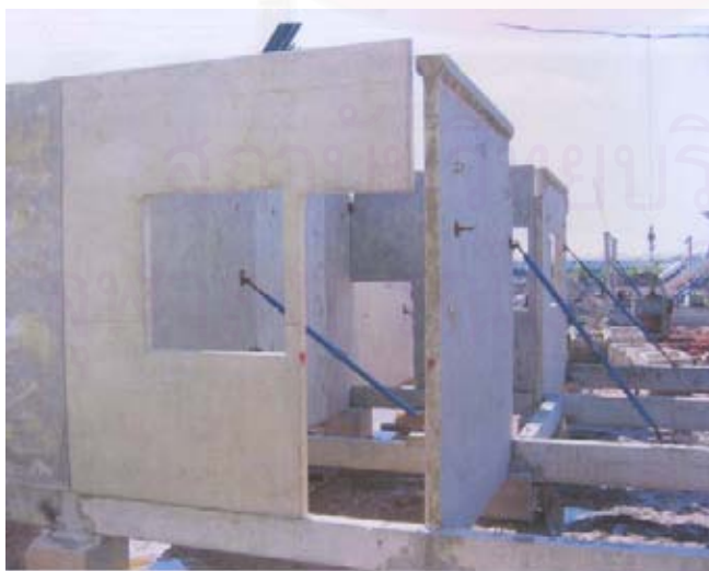
รูปที่ 5-13 แสดงการติดตั้งผนังชั้นล่าง
