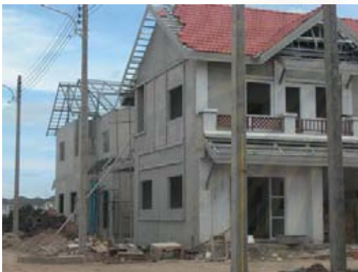
รูปที่ 5-28 งานมุงหลังคา
