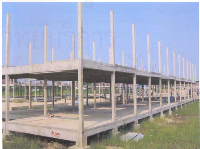
รูปที่ 5-7 แสดงการติดตั้งพื้นชั้นที่ 2
