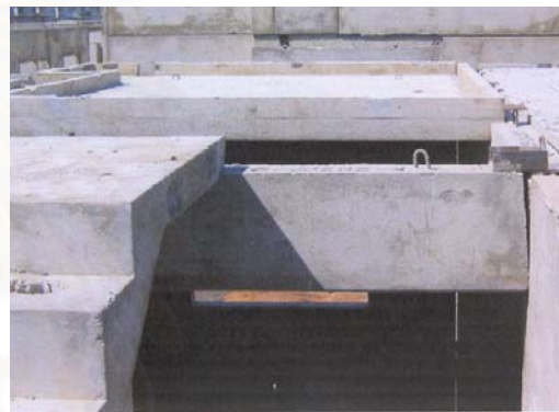
รูปที่ 5-21 แสดงการติดตั้งถาดห้องน้ำ
