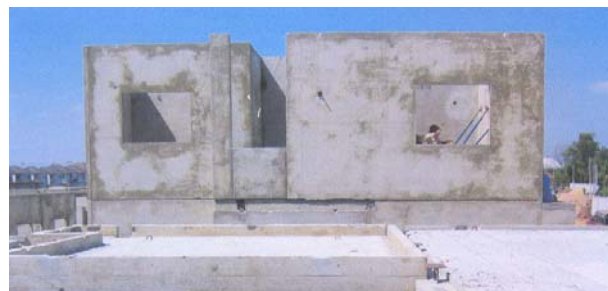
รูปที่ 5-23 แสดงการติดตั้งผนังชั้นที่ 2
