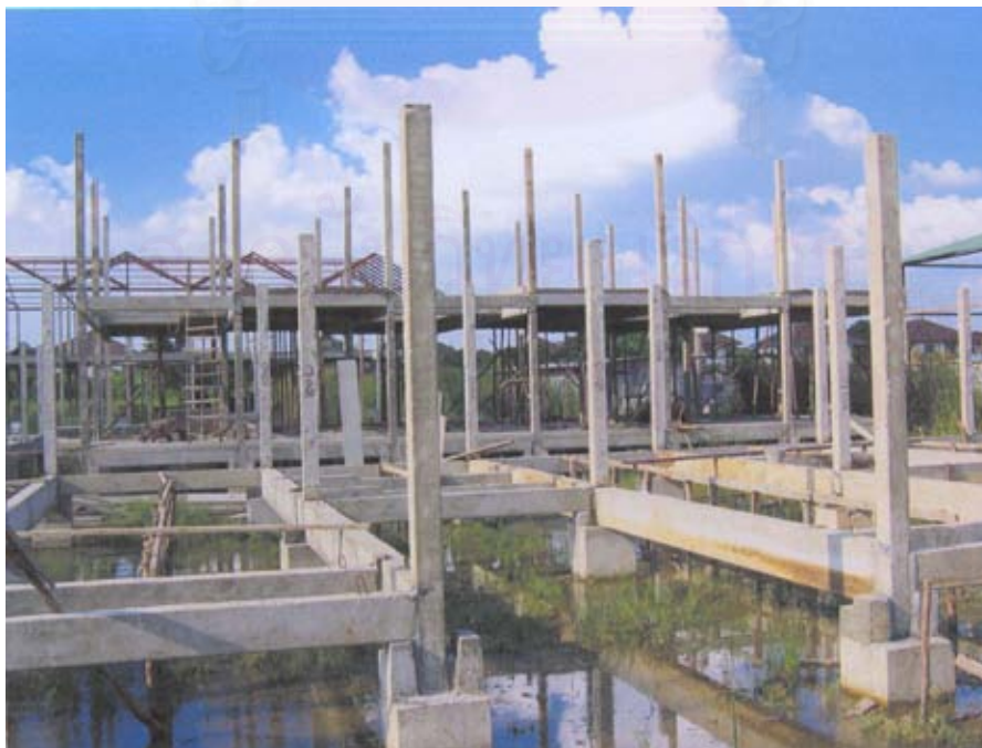
รูปที่ 5-3 แสดงการติดตั้งเสาชั้นล่าง
