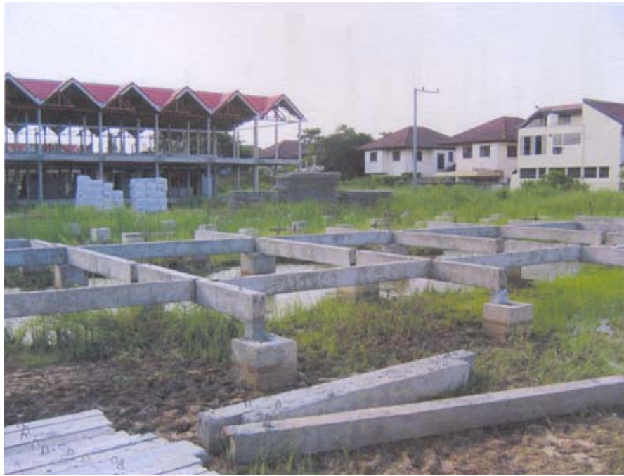
รูปที่ 5-2 แสดงการติดตั้งคานชั้นล่าง
