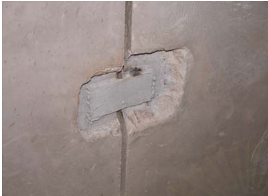
รูปที่ 5-15 แสดงการยึดติดผนัง โดยใช้เพลทเหล็ก
