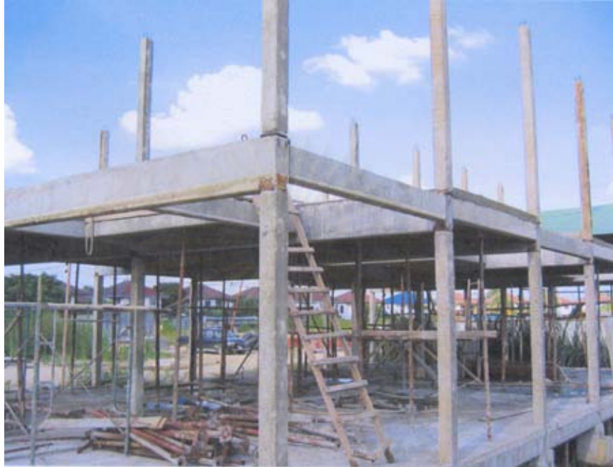
รูปที่ 5-6 แสดงการติดตั้งเสาชั้นที่ 2
