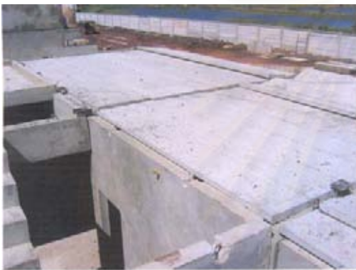
รูปที่ 5-20 แสดงการติดตั้งแผ่นพื้นสำเร็จ
