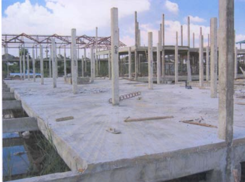
รูปที่ 5-4 แสดงการติดตั้งพื้นชั้นล่าง
