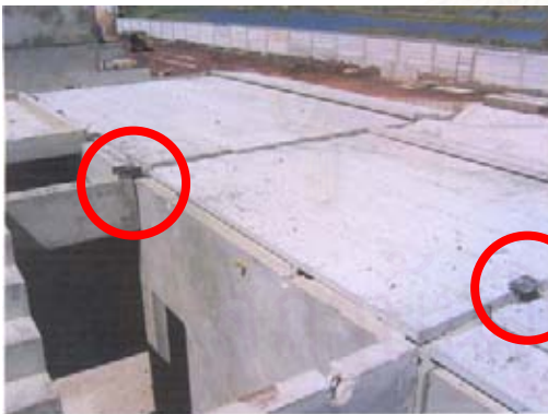
รูปที่ 5-22 แสดงการเชื่อมเพลทเหล็กเพื่อรับผนังชั้นที่ 2
