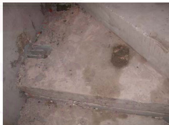
รูปที่ 5-19 แสดงรอยต่อบริเวณผนังกับลูก นอนบันได
