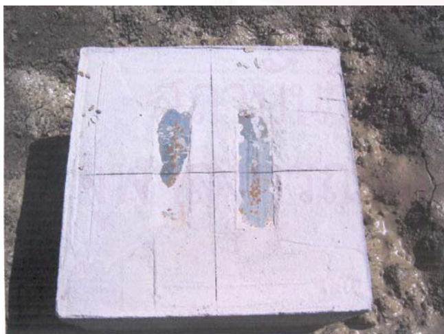
รูปที่ 5-11 แสดงการฝังเพลทเหล็กไว้บริเวณฐานราก
