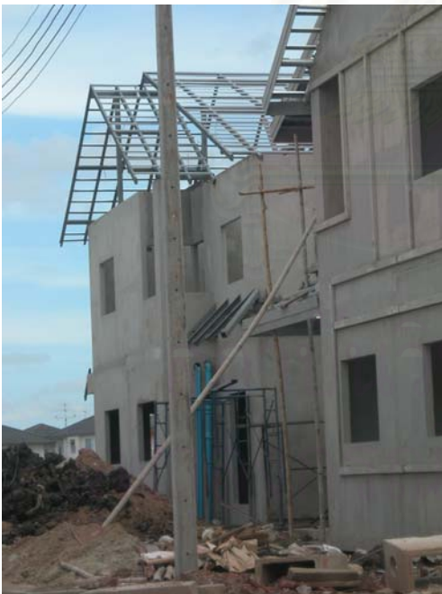
รูปที่ 5-27 แสดงงานขึ้นโครงหลังคาเหล็ก
