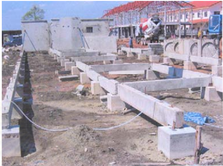
รูปที่ 5-12 แสดงการติดตั้งคานชั้นล่าง
