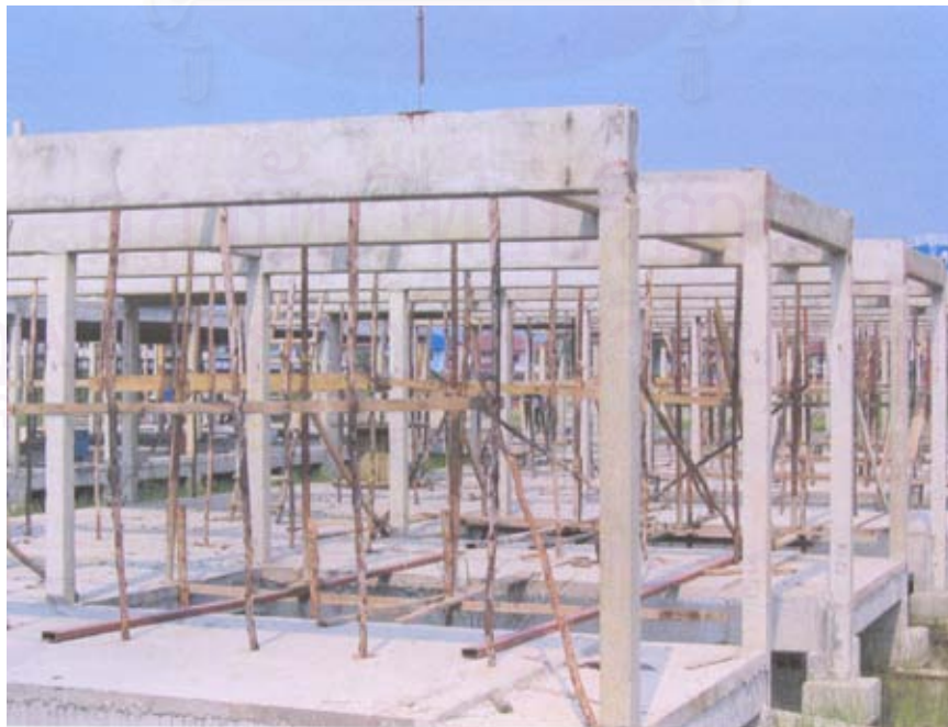
รูปที่ 5-5 แสดงการติดตั้งคานชั้นที่ 2
