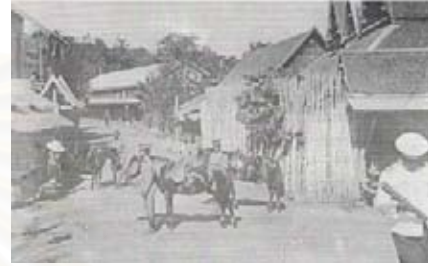
สภาพถนนคลองกระแซง
