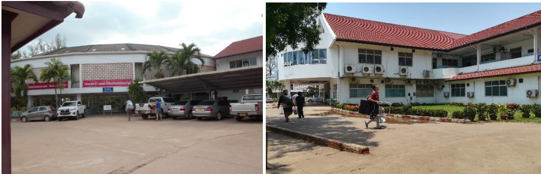
ภาพที่ 3.19 อาคารบริหาร และอาคารฉุกเฉิน
