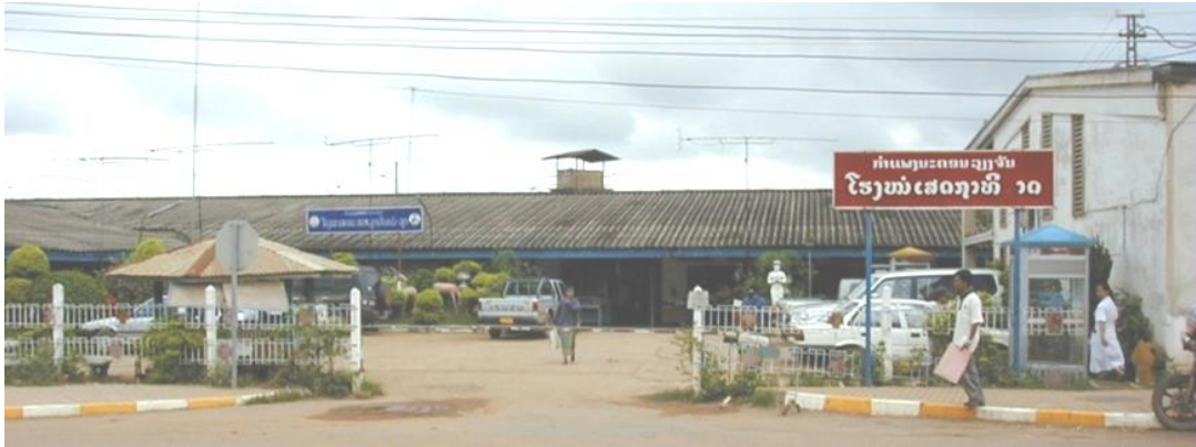
ภาพที่ 3.27 โรงพยาบาลหลังเก่า บริเวณถนนธาตุหลวง
