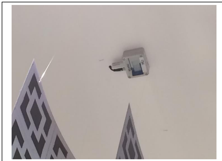
รูปที่ 3.6 เซ็นเซอร์วัดอุณหภูมิและความชื้นสัมพัทธ์ของอากาศ
