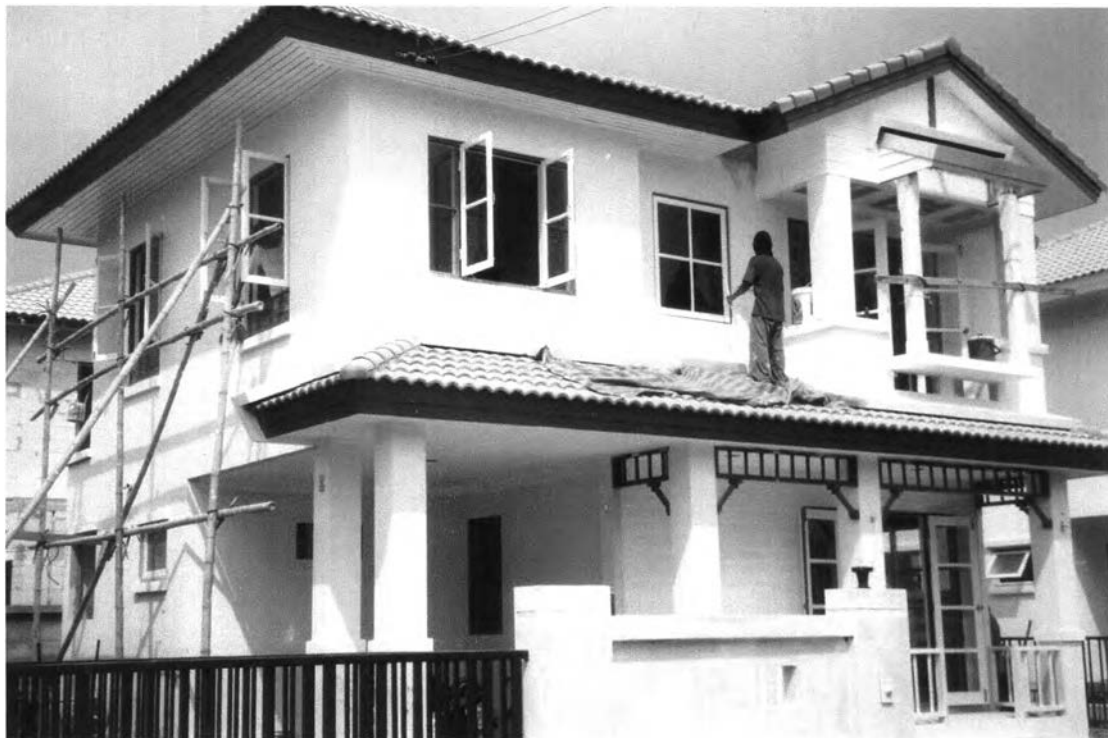
ภาพที่ 4 – 5 แบบบ้าน 052 ด้านข้าง ขณะทำการก่อสร้างไปได้ร้อยละ 90 เมื่อเดือน มกราคม 2546
