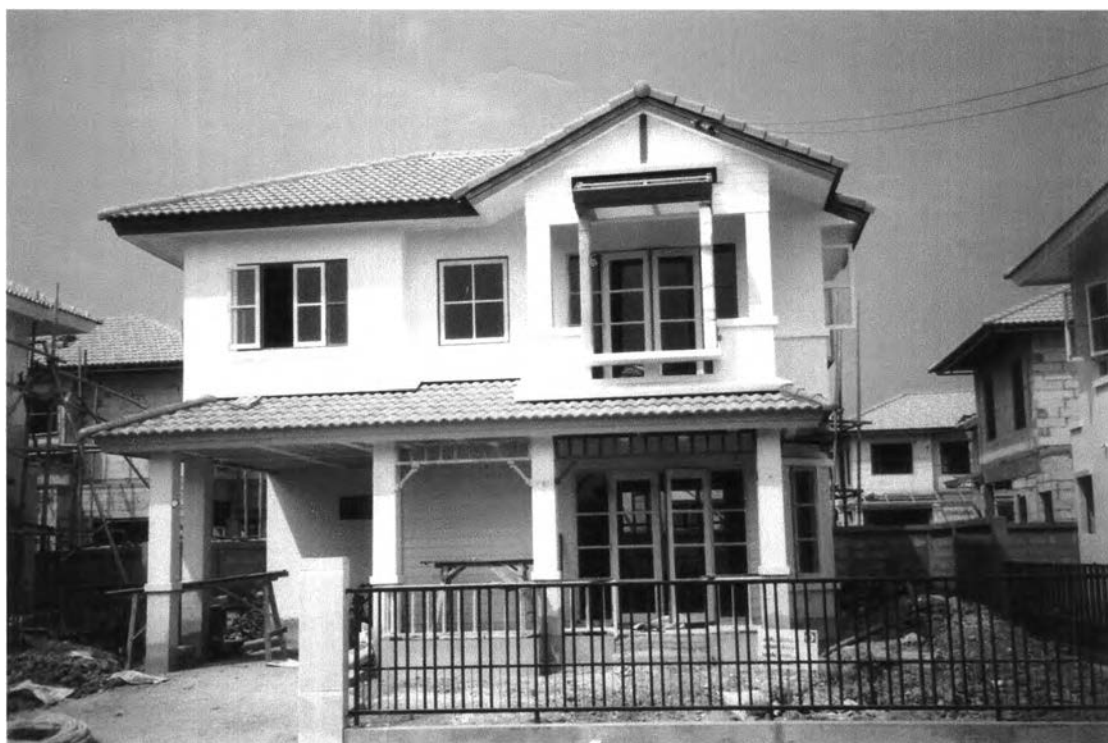
ภาพที่ 4 – 6 แบบบ้าน 052 ด้านหน้า ขณะทำการก่อสร้างไปได้ร้อยละ 90 เมื่อเดือน มกราคม 2546
