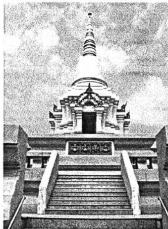
ภาพที่ 6.1.2 พระมหาธาตุเจดีย์ศรีจันเสน วัดจันเสน จ. นครสวรรค์ ออกแบบโดย อ.วนิดา พึ่งสุนทร ประดิษฐานพระบรมสารีริกธาตุที่ชั้นบน ส่วนชั้นล่างใช้เป็นที่จัดแสดง
