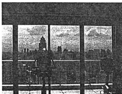
ภาพที่ 4.11 แสดงการเลือกใช้ผนังกระจกสองชั้น (Double Glazing) เพื่อป้องกันเสียงรบกวน
