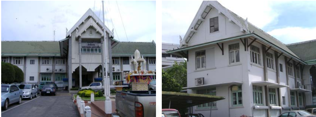
ภาพที่ 4.2 แสดงภาพถ่ายด้านหน้าอาคารที่หันไปทางทิศใต้และด้านหลังอาคารที่หันไปทางทิศเหนือ
