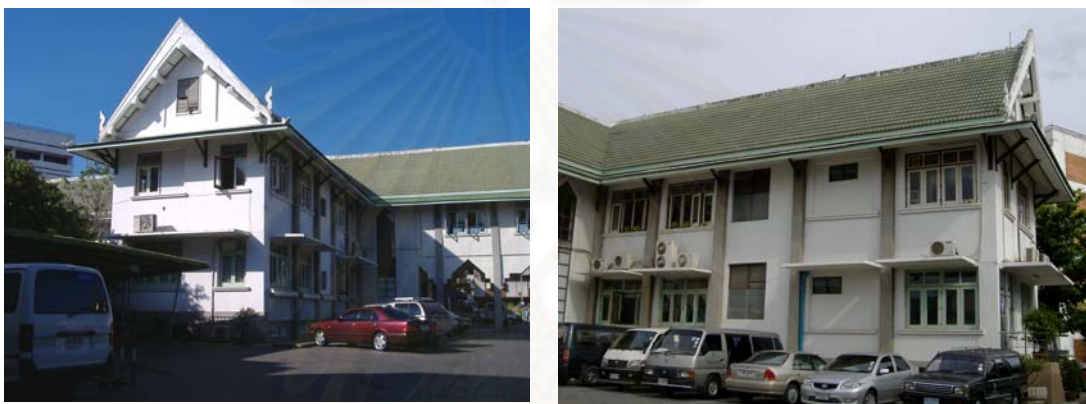
ภาพที่ 4.3 แสดงภาพถ่ายด้านขวาอาคารที่หันไปทางทิศตะวันตกและด้านซ้ายอาคารที่หันไปทางทิศตะวันออก
