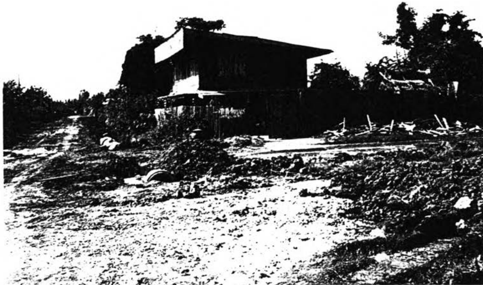
ภาพที่ 5.75 สภาพของถนนเป็นถนนดิน ไม่มีท่อระบายน้ำเป็นส่วนาพญ
