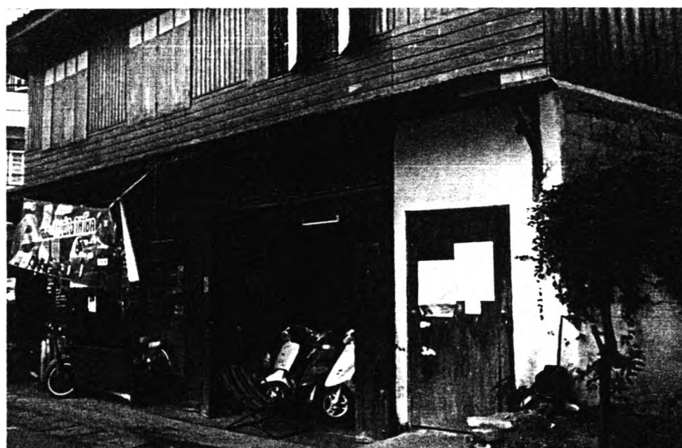
ภาพที่ 5.69 ภาพอาคารเรือนแถวไม้ 2 ชั้น ริมถนนคลองกระแชง
