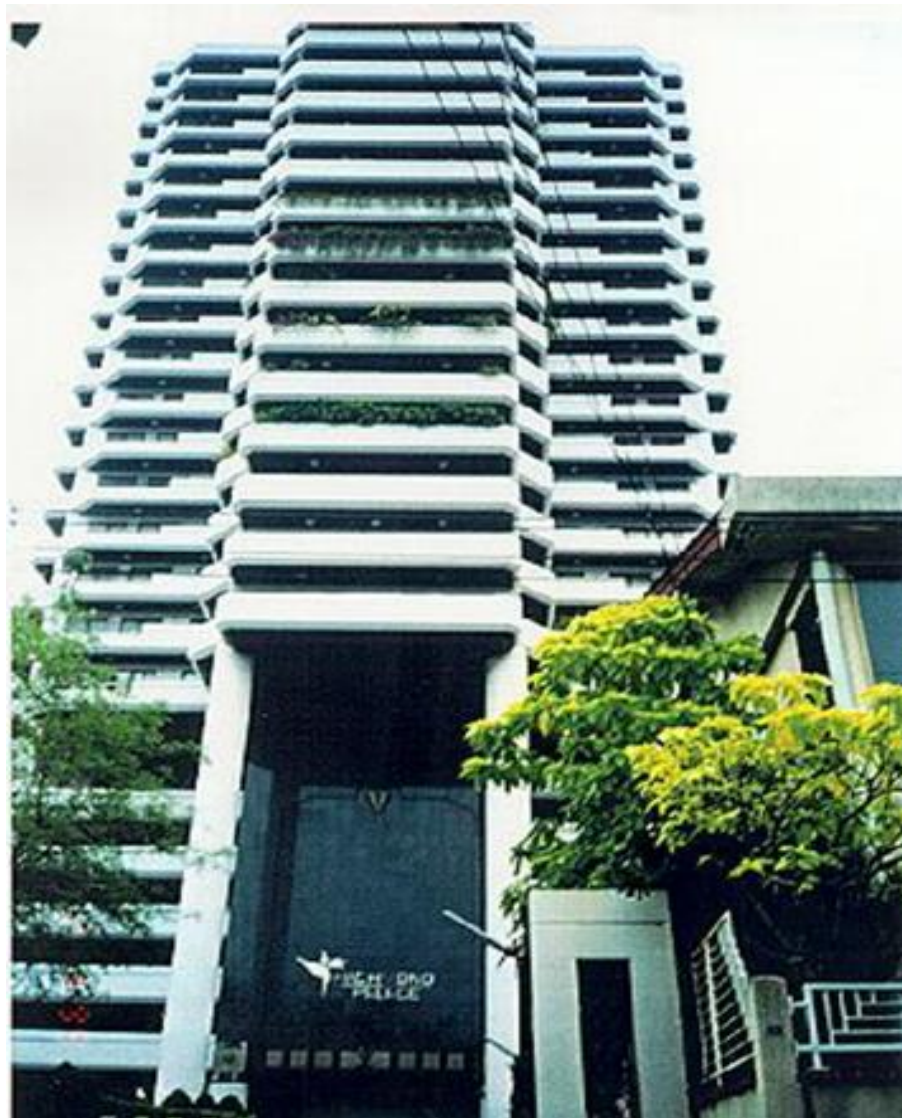
ภาพที่ 25 อาคารกรณีศึกษาอาคาร B
