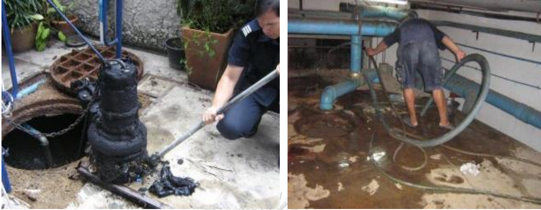
ภาพที่ 32 ระบบบำบัดน้ำเสียอาคาร B
