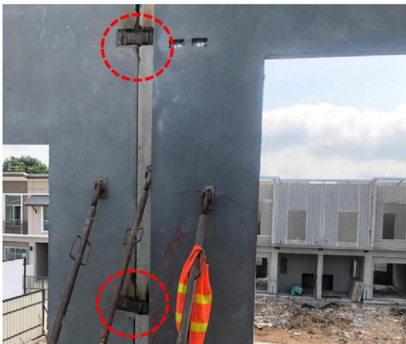
รูปที่ 76 การใช้เฟลทเหล็กบริเวณรอยต่อระหว่างผนังภายใน
