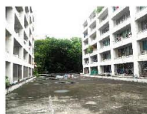
ค. ลานคอนกรีตเชื่อมระหว่างอาคารพักอาศัย (ลานคาดฟ้าที่จอดรถใต้ดิน)
