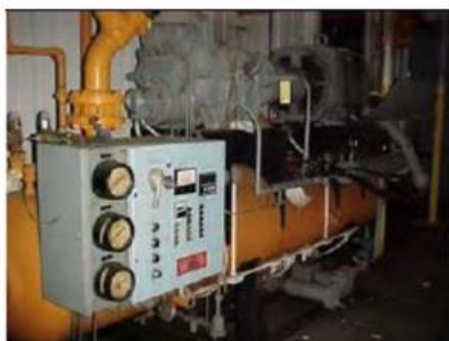
ก) เครื่องอัดน้ำยาซึ่งส่วนใหญ่จะเป็น แบบสกปรู นิยมใช้เครื่องอัดน้ำยาแบบ สกปรูเนื่องจากราคาถูกกว่าแบบอื่นๆ
