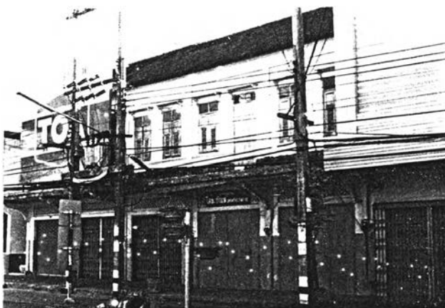
ภาพที่ 5.8 สภาพภูมิทัศน์ด้านหน้าอาคารเก่าที่ทรุดโทรมเนื่องจากสภาพที่เสื่อมถอยของเส้าไฟฟ้า
