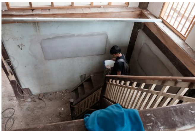
ภาพ 4-5 ภาพพื้นบริเวณบันไดถูกตัดออกเพื่อเพิ่มความโปร่งและสว่างภายในเรียน
