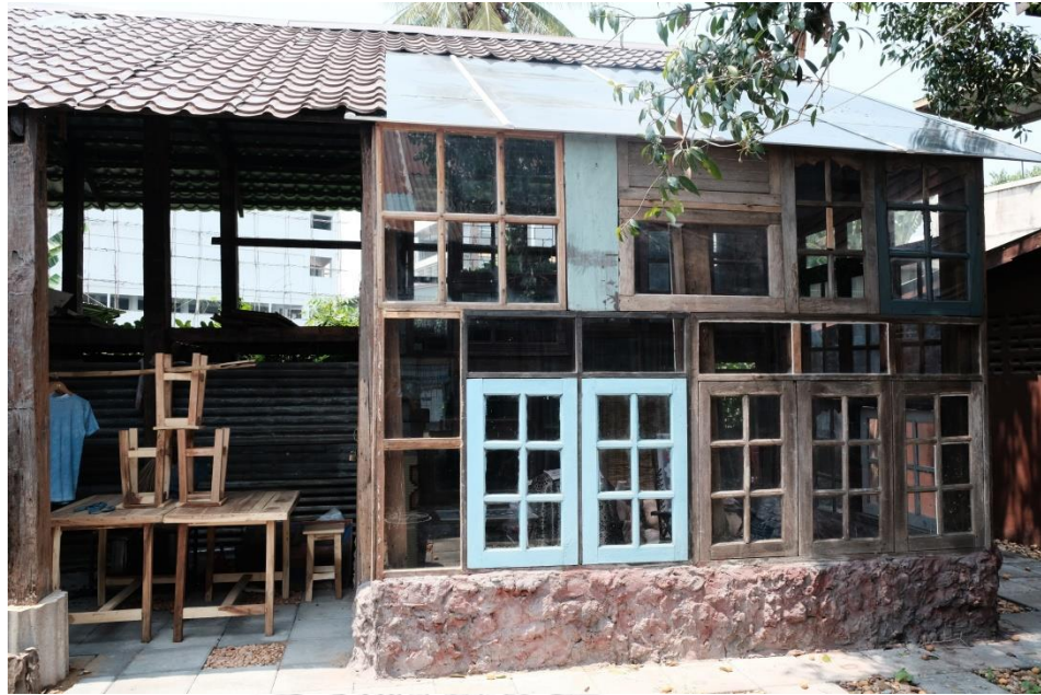
ภาพ 4-23 นำหน้าต่างเก่ามาขึ้นห้องเพื่อสร้างพื้นที่ทำงานและเก็บของ ที่มา : ผู้วิจัย, เมษายน 2561
