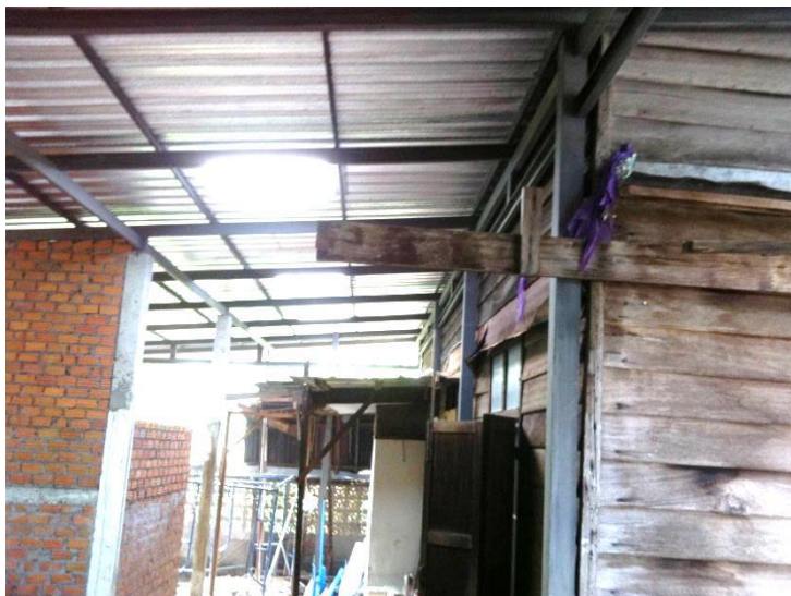
ภาพ 4-67 ต่อเติมเรือนทางด้านหลังโดยทำโครงสร้างแยกจากตัวเรือนเดิม ที่มา : นิตากร หงษ์สกุล, 2557
