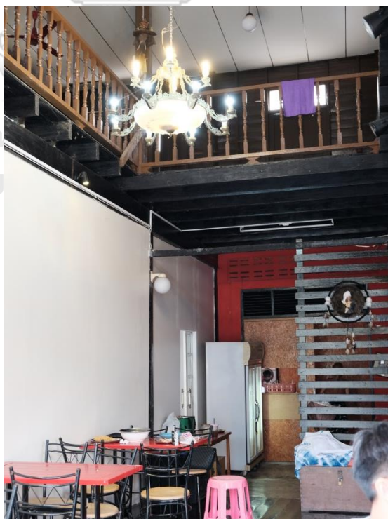
ภาพ 4-14 ภาพหลังการดำเนินงานดัดแปลงพื้นไม้ชั้นสอง ที่มา : ผู้วิจัย, เมษายน 2561
