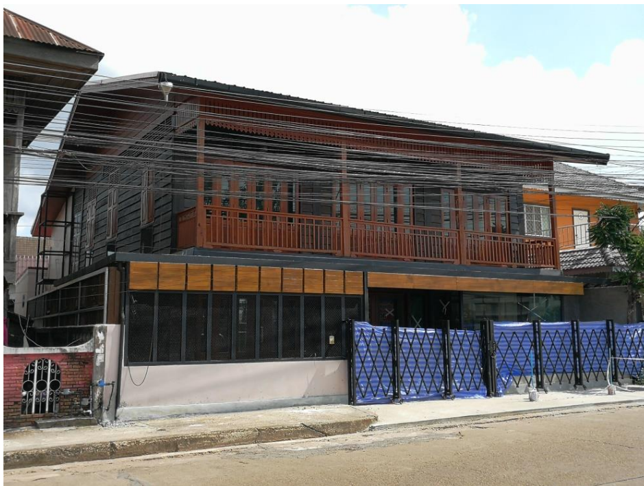
ภาพ 4-2 ภาพอาคารกรณีศึกษา A ภายหลังจากการอนุรักษ์และฟื้นฟูแล้วเสร็จเมื่อปี 2562
