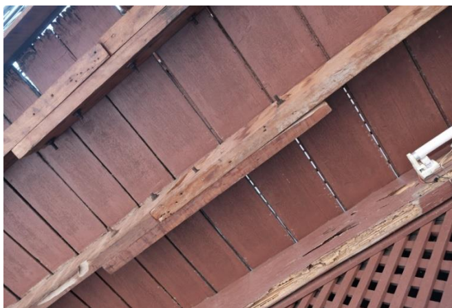
ภาพ 4-59 นำไม้เก่ามาตามเสริมความแข็งแรงของโครงสร้างพื้นระเบียง
