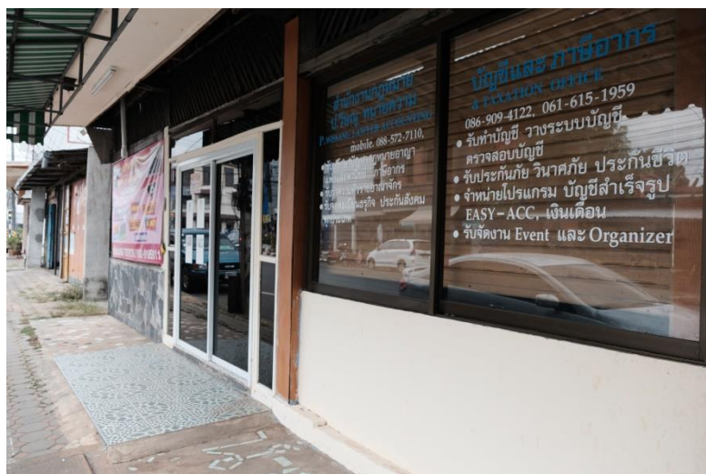
ภาพ 4-53 ผนังก่ออิฐฉาบปูนและบานอลูมิเนียมกระจกบริเวณทางเข้าเรือน
