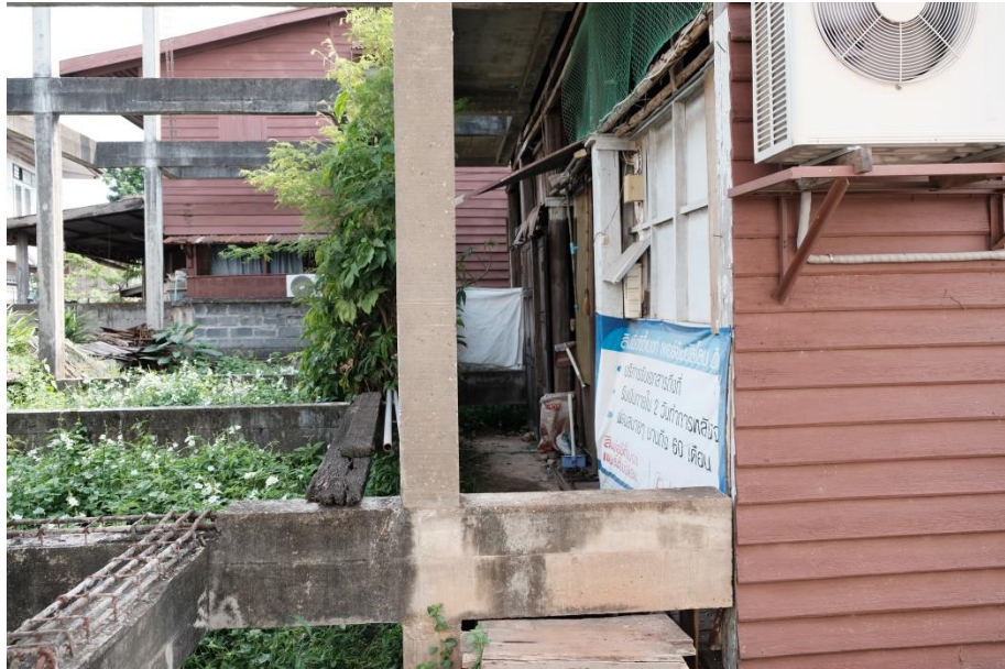
ภาพ 4-74 ต่อเติมอาคารใหม่ขีดทางด้านหลังด้วยโครงสร้างคอนกรีตเสริมเหล็ก ที่มา : ผู้วิจัย, เมษายน 2561
