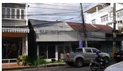
ภาพ 3-23 ตัวอย่างเรือนที่ถูกทิ้งร้างและสภาพผิวภายนอกเปลี่ยนแปลงไปมาก
