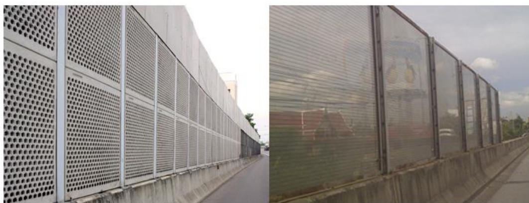
ภาพที่ 39 ลักษณะของผนังกันเสียงแบบกระจายเสียง (Dispersive Panel) ที่มา : ( https://www.pcm.co.th/noise-barrier/ , เข้าถึงเมื่อ กุมภาพันธ์ 2564)
