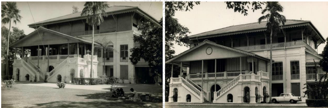
(ซ้าย) ก่อนการบูรณะ พ.ศ. 2504 (ขวา) หลังการบูรณะ ปี พ.ศ. 2505
