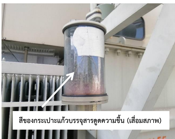
รูปที่ 17 กระเปาะแก้วบรรจุสารดูดความชื้นเสื่อมสภาพ
