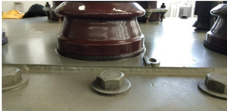
รูปที่ 14 ปะเก็นมีรอยคราบน้ำมันหรือปะเก็นเสื่อมคุณภาพ
