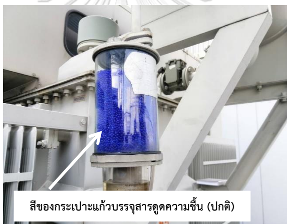
รูปที่ 16 สีของกระเปาะแก้วบรรจุสารดูดความชื้น
