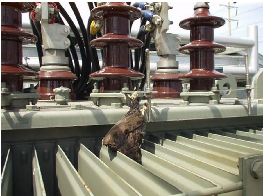
รูปที่ 1 สาเหตุการเสื่อมสภาพซึ่งเกิดมาจากสัตว์ (นก)
