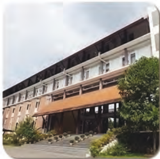
อาคารวิชาคาม ๑ อาคารที่ตั้งศูนย์ ห้องเรียน ห้องสมุด
