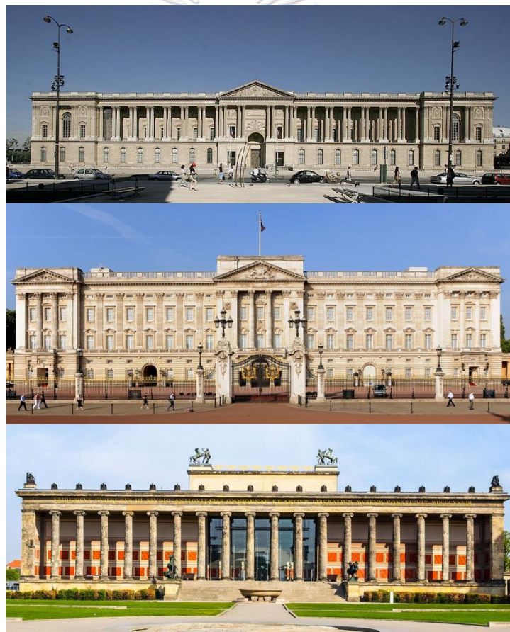
ภาพที่ 240 (จากบนลงล่าง) รูปด้านหน้าของพระราชวังลูฟร์ (Louvre Palace) พระราชวังบักกิงแฮม (Buckingham Palace) และพิพิธภัณฑ์อัลเตส (Altes Museum) แสดงการออกแบบสถาปัตยกรรมในรูปแบบฟื้นฟูศิลปวิทยาการ (Neoclassical Architecture) โดยใช้แบบแผนอาคารสามชั้น (Three Storeys Scheme) และแบบแผนพอร์ติโค (Portico) (ที่มา: https://commons.wikimedia.org , https://www.royal.uk/ )
