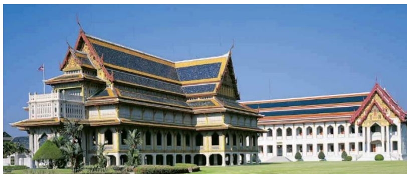
ภาพที่ 258 หอสวด และอาคารวชิรมงกุฏ วชิราวุธวิทยาลัย แสดงการออกแบบอาคารใหม่ให้เป็นพื้นหลัง และส่งเสริมอาคารเดิม ซึ่งเป็นประธานของผังบริเวณ รวมถึงมีรูปแบบสถาปัตยกรรมที่สอดคล้องกัน (ที่มา: สมาคมสถาปนิกสยามฯ)
