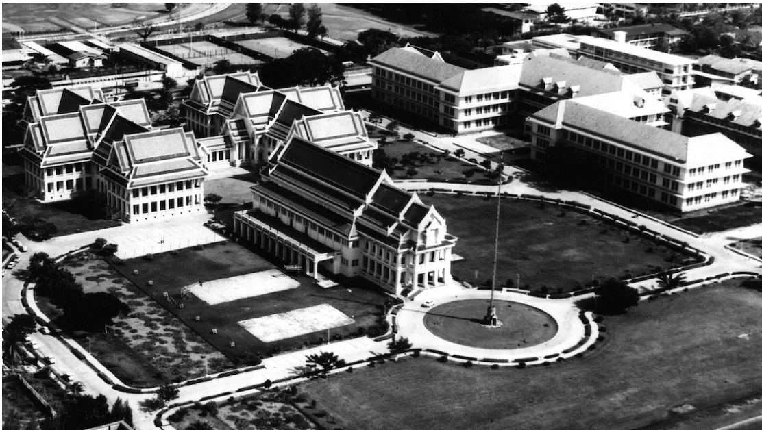
ภาพที่ 78 หอประชุมจุฬาลงกรณ์ มหาวิทยาลัย ในปี พ.ศ. 2509 หลังการต่อเติมปีกทั้งสองข้างของอาคาร (ที่มา: หอประวัติ จุฬาฯ)
