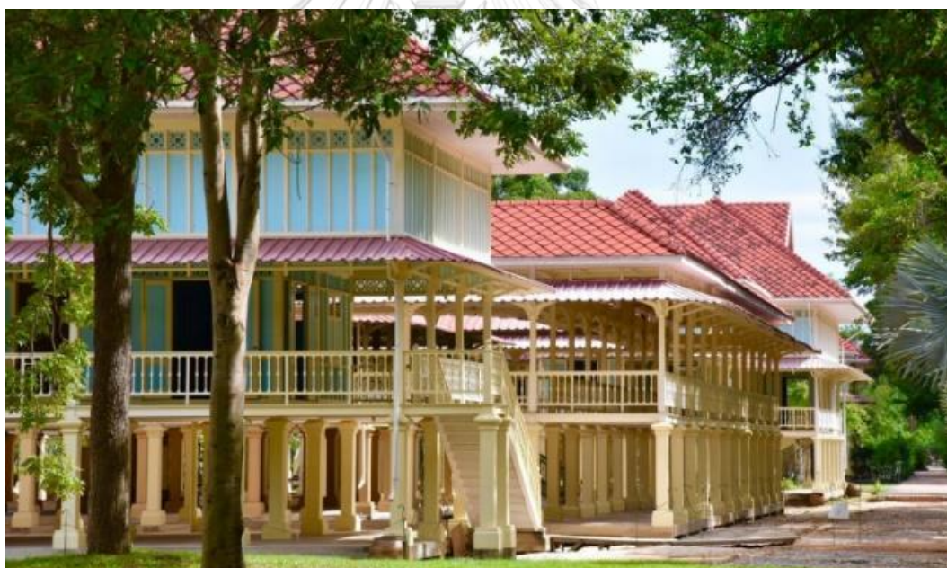
ภาพที่ 259 สถาปัตยกรรมในพระราชนิเวศน์มฤคทายวัน แสดงลักษณะของ สถาปัตยกรรมที่ตอบรับภูมิอากาศแบบร้อนชื้น มีได้ถุนสูง ระเบียงกันแดด และรั้วลม ช่องลม หลังคากันสาด และหลังคาสเกิร์ต รวมถึงการเชื่อมอาคารด้วยฉนวน
