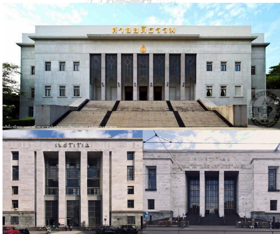
ภาพที่ 166 อาคารที่ทำการกระทรวงยุติธรรม (บน) โดยพระสาโรชรัตนนิมมานก์ และอาคารศาลยุติธรรมแห่งมิลาน (Palazzo di Giustizia, Milan) (ล่าง) โดยมาร์เซลโล ปิอาเซนตินี (Marcello Piacentini) (ที่มา: https://asaconservationaward.com/ , ผู้วิจัย)
