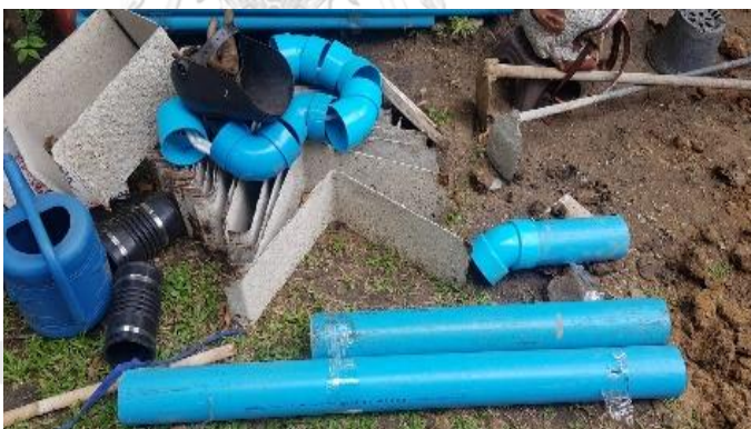
ภาพที่ 70 งานต่อท่องานระบบสุขาภิบาล
