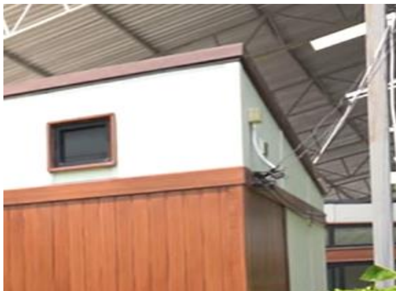
ภาพที่ 42 จุดเชื่อมต่องานระบบไฟฟ้า ตารางที่ 2 สรุปลำดับวิธีการก่อสร้างบ้านโครงสร้างหลักของบริษัท B
