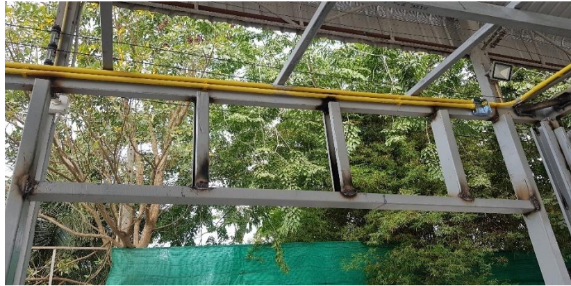
ภาพที่ 29 งานติดตั้งท่องานระบบไฟฟ้า
