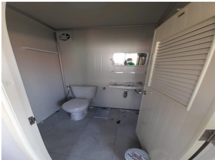
ภาพที่ 49 งานปูกระเบื้องพื้นและติดตั้งอุปกรณ์ภายในห้องน้ำ
