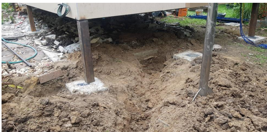
ภาพที่ 58 งานติดตั้งเสาเข็มของบริษัท D
