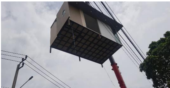
ภาพที่ 69 งานยกติดตั้งบ้าน
