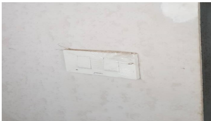
ภาพที่ 65 งานติดตั้งสวิตซ์งานระบบไฟฟ้า
