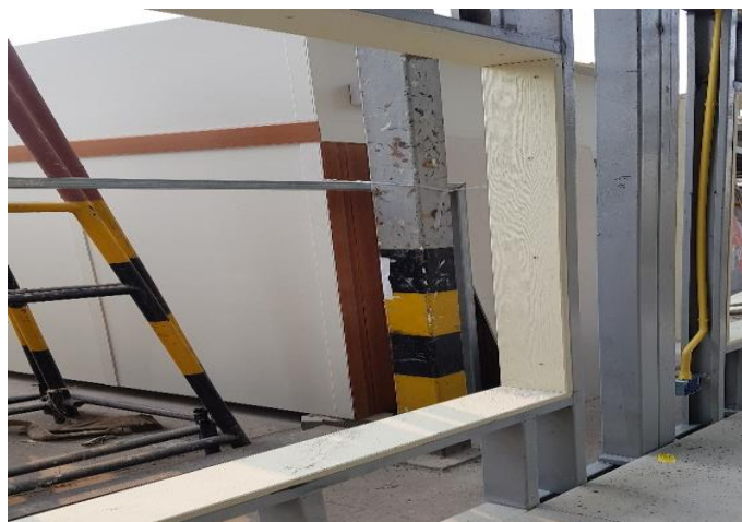
ภาพที่ 26 งานติดตั้งวงกบประตู-หน้าต่างในขั้นตอนงานผนัง
