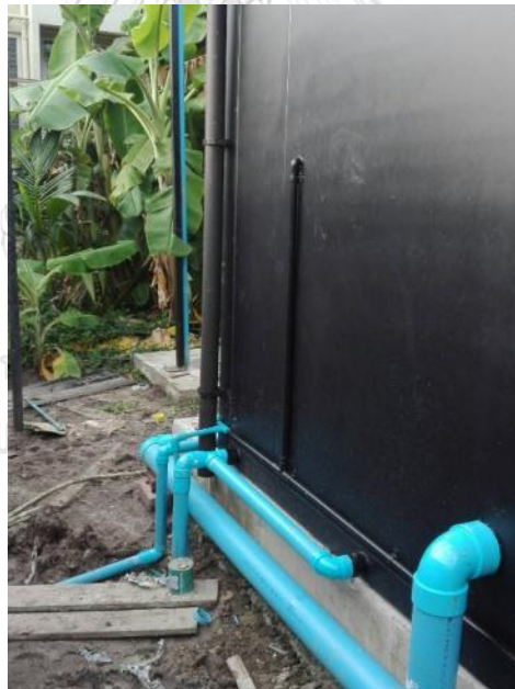
ภาพที่ 20 การต่อท่อสุขาภิบาล
