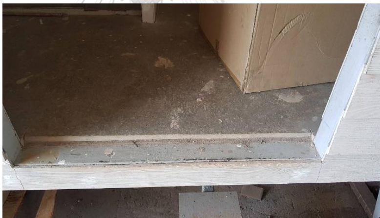
ภาพที่ 60 งานติดตั้งพื้นไฟเบอร์ซีเมนต์ ขนาด 16 มิลลิเมตร
