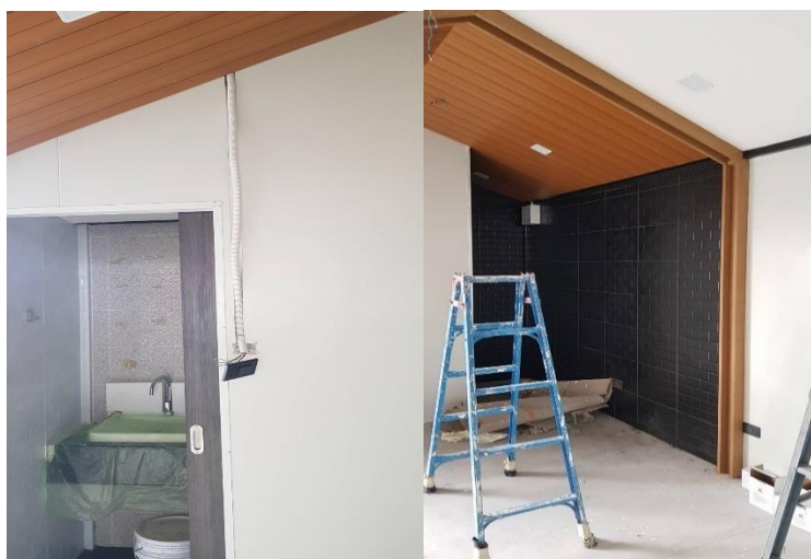
ภาพที่ 15 งานติดตั้งระบบไฟฟ้าที่ผนัง
