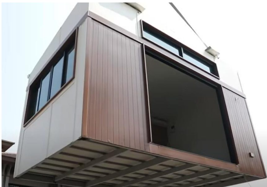
ภาพที่ 40 การดำเนินงานยกติดตั้งบ้าน
