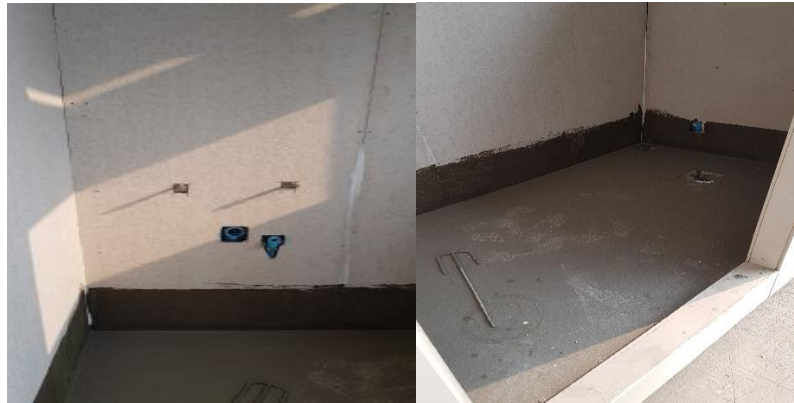
ภาพที่ 32 งานระบบกันชื้นห้องน้ำ
