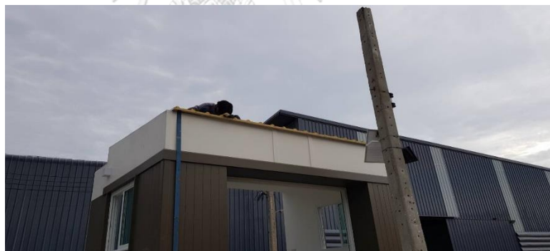
ภาพที่ 35 งานติดตั้งหลังคาเมทัลชีท
