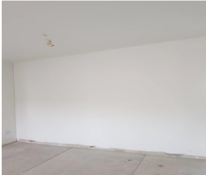
ภาพที่ 36 งานติดตั้งฝ้าเพดาน
