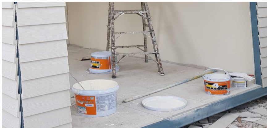
ภาพที่ 47 งานติดตั้งพื้นไฟเบอร์ซีเมนต์
