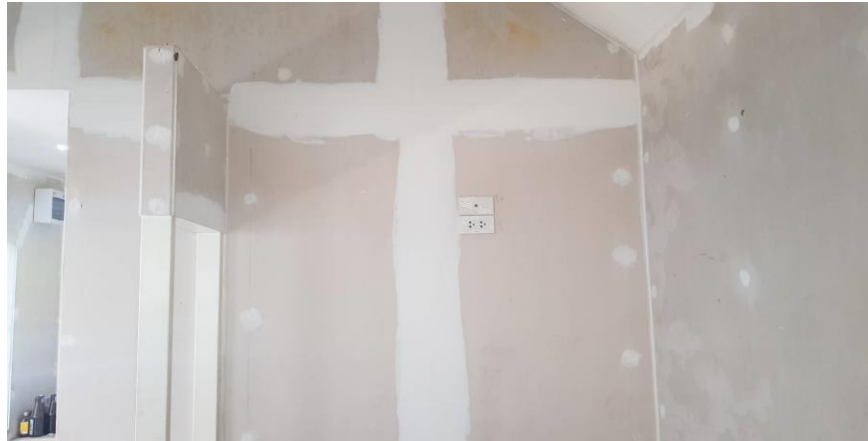
ภาพที่ 61 งานติดตั้งผนังไฟเบอร์ซีเมนต์
