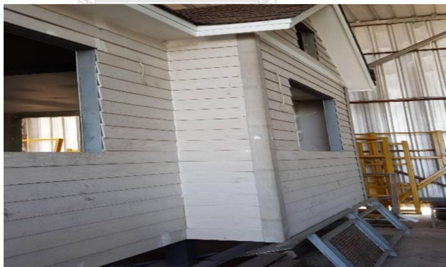
ภาพที่ 62 งานติดตั้งผนังภายนอก
