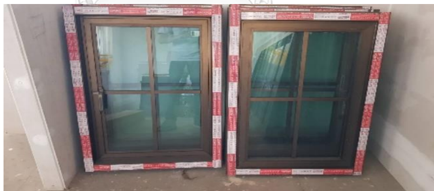
ภาพที่ 66 หน้าต่างสำเร็จรูปที่รอการติดตั้ง
