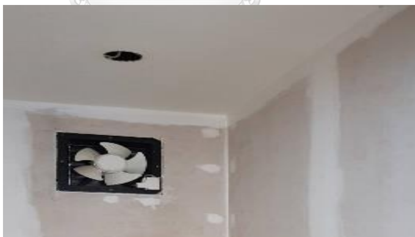
ภาพที่ 64 งานติดตั้งฝ้าเพดาน
