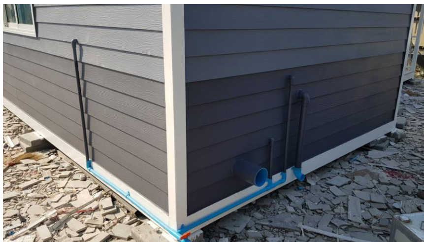
ภาพที่ 55 ท่องานระบบสุขาภิบาล
