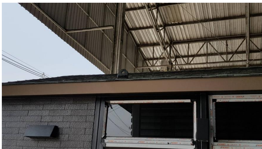
ภาพที่ 11 งานประกอบหลังคา
