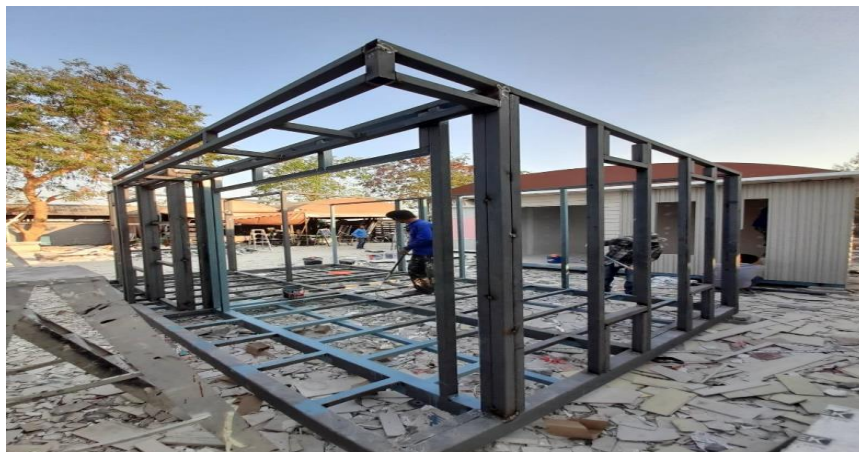
ภาพที่ 45 ประกอบโครงสร้างเหล็กและทาสีเหล็กรูปพรรณ
