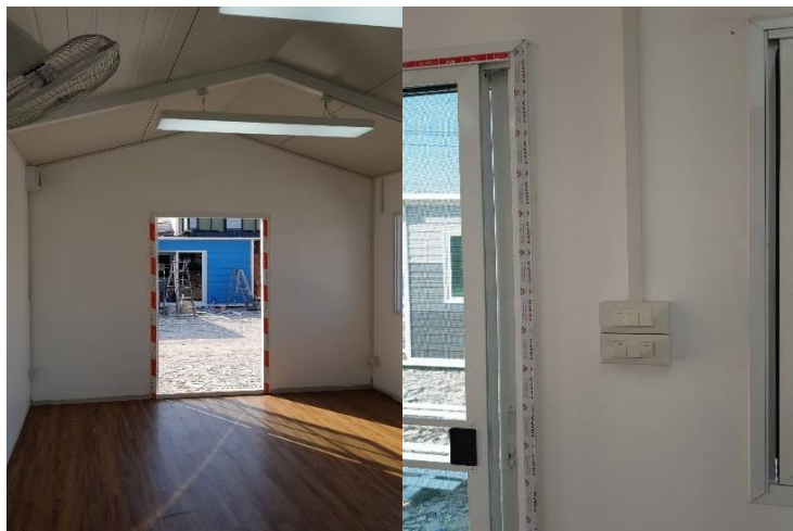
ภาพที่ 51 งานติดตั้งระบบไฟฟ้า
