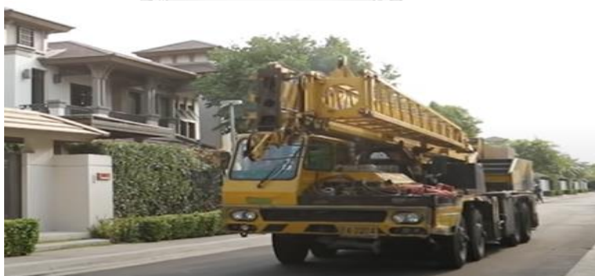
ภาพที่ 39 การเตรียมงานยกติดตั้งบ้าน
