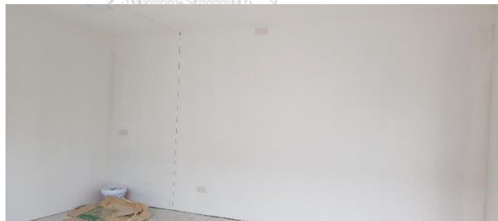
ภาพที่ 30 งานติดตั้งแผ่นผนังไฟเบอร์ซีเมนต์
