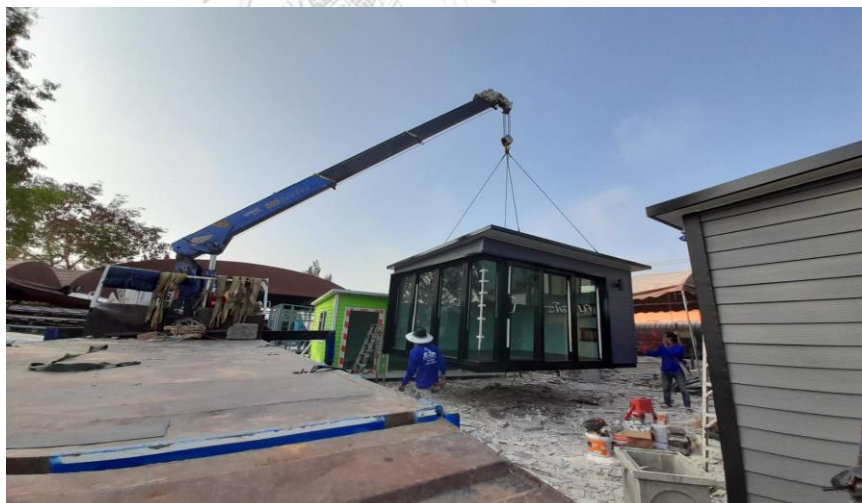
ภาพที่ 54 การยกบ้านเพื่อขนส่งไปพื้นที่ก่อสร้าง
