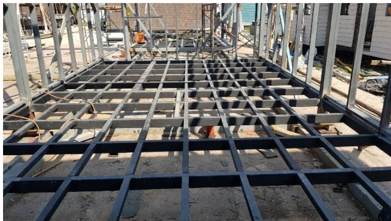
ภาพที่ 59 งานประกอบโครงสร้างเหล็ก
