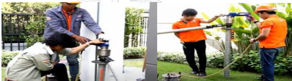
ภาพที่ 23 งานติดตั้งเสาเข็มเหล็กสำเร็จรูป
