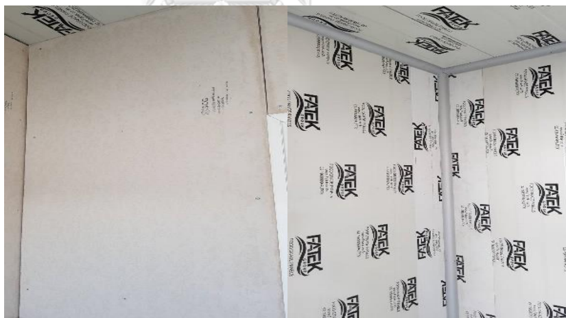
ภาพที่ 48 งานติดตั้งแผ่นผนังไฟเบอร์ซีเมนต์และแผ่น ISOWALL
