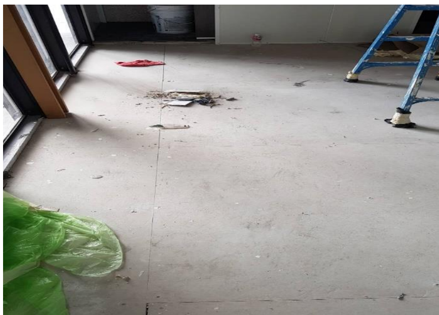
ภาพที่ 13 งานติดตั้งพื้นไฟเบอร์ซีเมนต์
