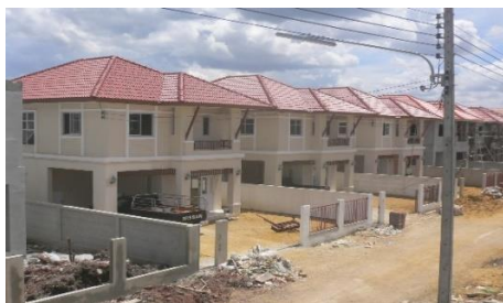
ภาพที่ 4- 3 ที่ดินพร้อมสิ่งปลูกสร้างระหว่างก่อสร้าง
