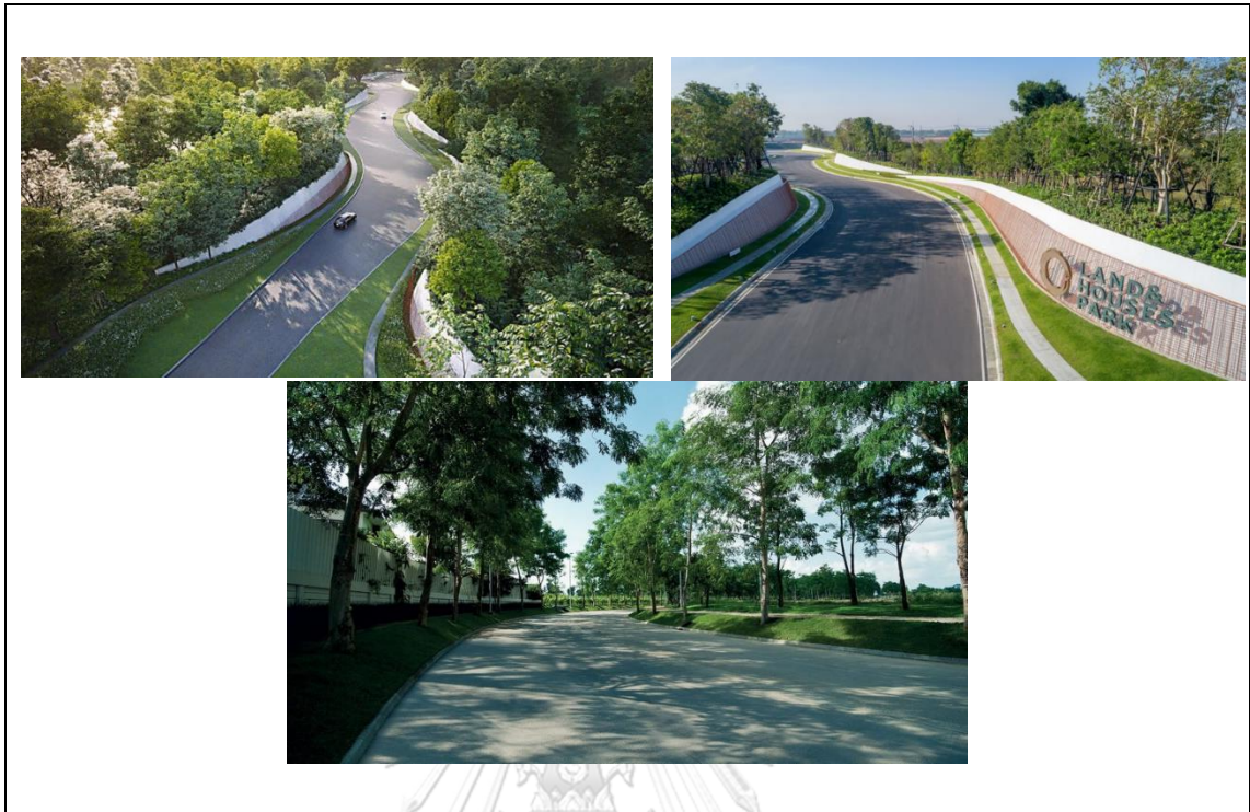
ภาพที่ 4- 16 ถนนการะจ่ายอม (นอกพื้นที่โครงการจัดสรร)
