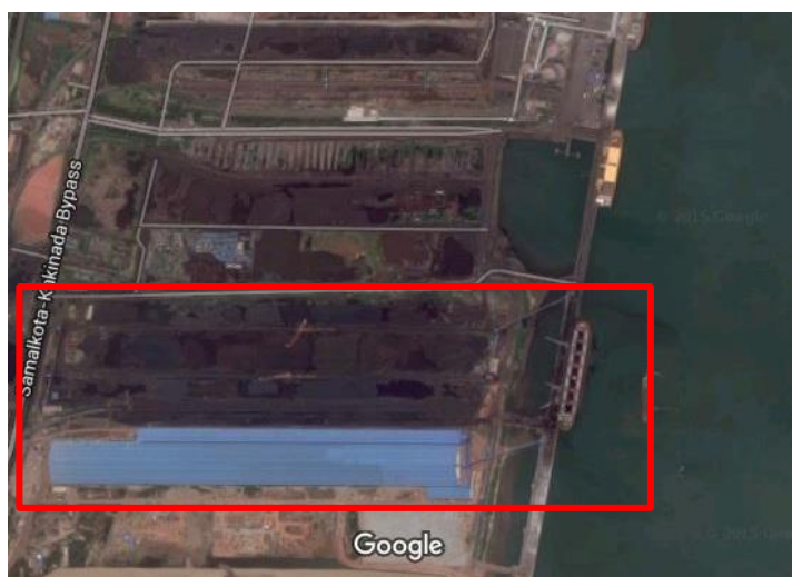
รูปที่ 3.4-7 KDWP Coal Terminal, India
