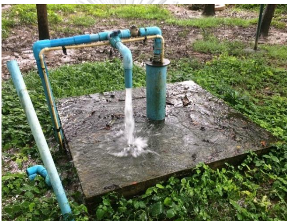
ภาพที่ 23 บ่อบาดาลสำหรับระบบกรองน้ำเพื่อการบริโภค
