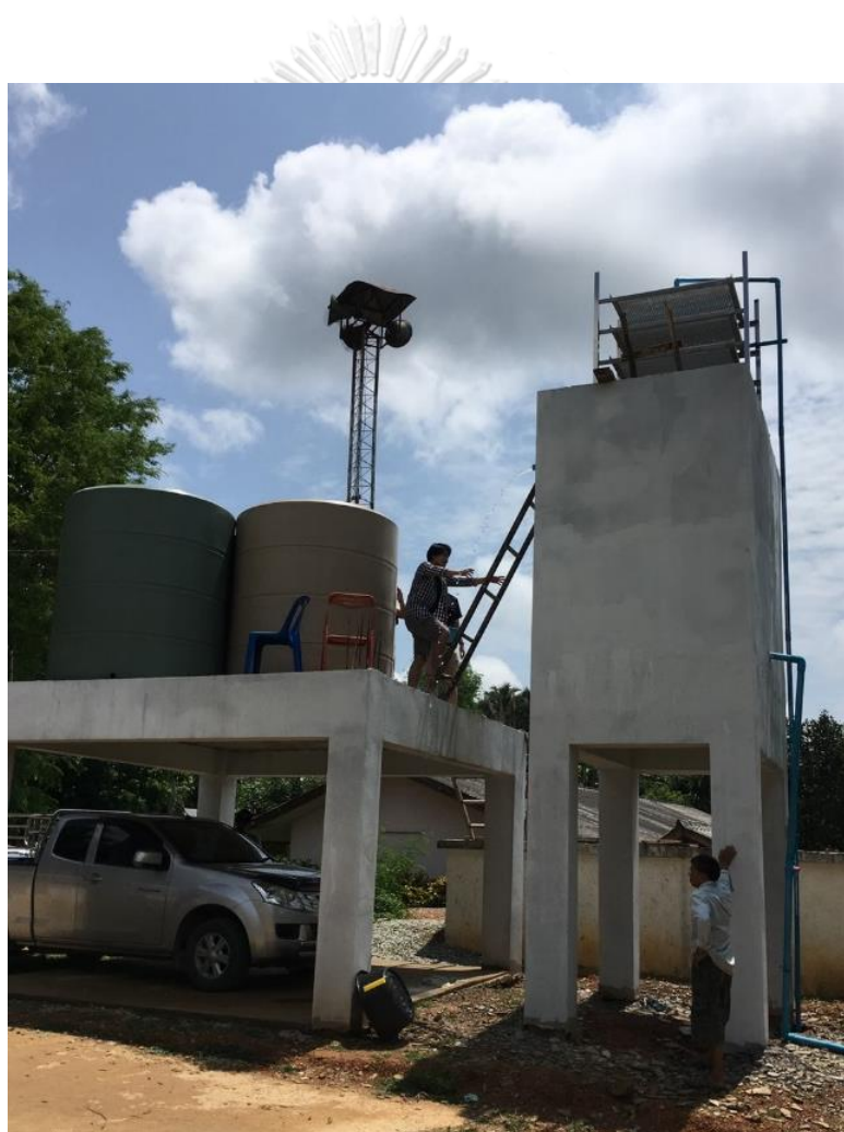
ภาพที่ 13 หอกรองน้ำที่เสร็จสมบูรณ์
