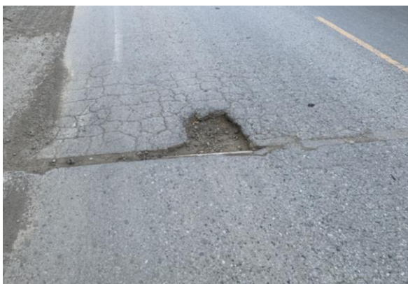
รูปที่ 2-1 ความเสียหายประเภทหลุมบ่อ
