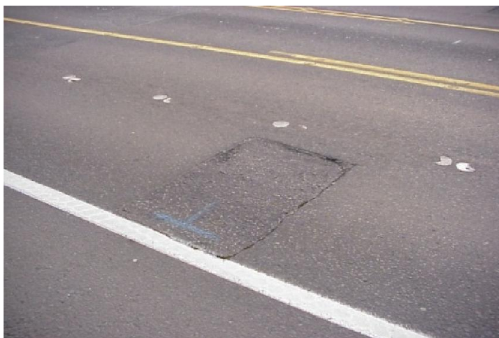
รูปที่ 2-4 ความเสียหายประเภทรอยปะซ่อมที่เสียหาย
