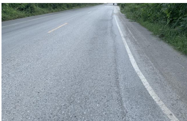
รูปที่ 2-3 ความเสียหายประเภทร่องล้อ
