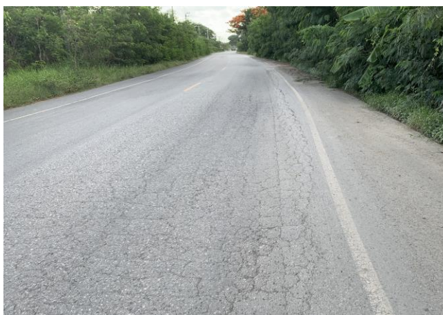
รูปที่ 2-2 ความเสียหายประเภทยุบตัวเป็นแอ่ง
