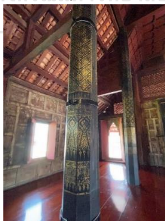
รูปที่ 6 เสาภายในชุดที่ 4 มีร่องรอยฝาพระตำหนักเดิมที่ถูกถอดออกเมื่อเป็นศาลาการเปรียญ (ที่มา: ผู้วิจัย, 2564)
