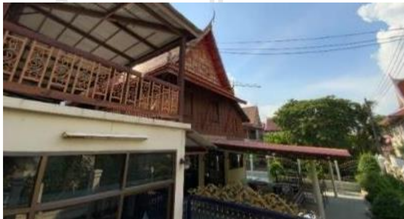
รูปที่ 50 ตำหนักเขียวในปัจจุบัน มีการต่อเติมใต้ถุนเพื่อการใช้งาน (ที่มา: ผู้วิจัย, 2564)
