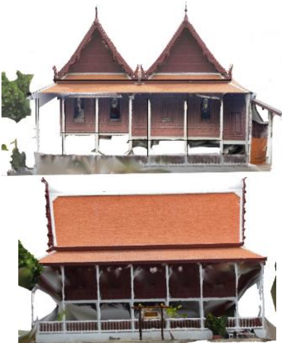
รูปที่ 129 ผลลัพธ์โฟโตแกรมเมตรี พระตำหนักแดง วัดเขมาภิรตาราม (ที่มา: ผู้วิจัย, 2564)
