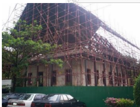
รูปที่ 87 (ซ้าย) พระที่นั่งมูลมณเฑียรบูรณะเมื่อ พ.ศ. 2550 มีการเปลี่ยนวัสดุในรูปแบบเดิม
