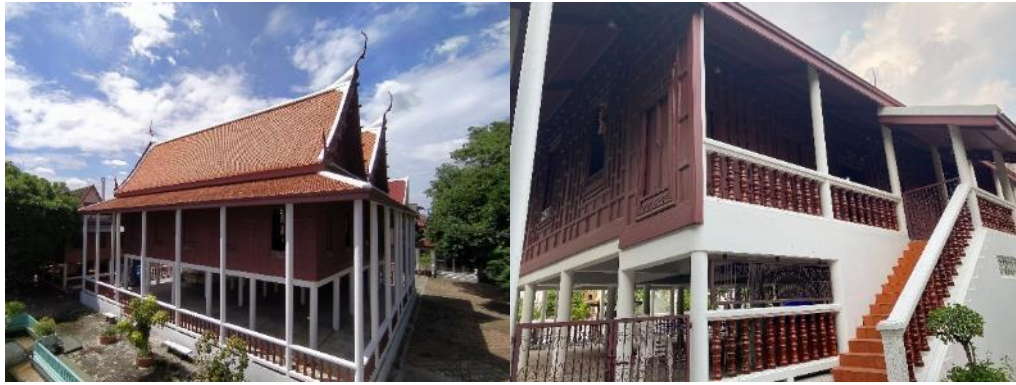
รูปที่ 83 พระตำหนักแดงในปัจจุบัน มีการรื้อใต้ถุนเมื่อแรกก็ลพนา เปลี่ยนเป็นคอนกรีต (ที่มา: ผู้วิจัย, 2564)
