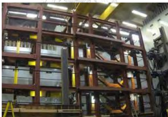
รูปที่ 2.1 อาคารโครงสร้างต้านแรงดัดเหล็ก หรือ steel moment resisting frame
