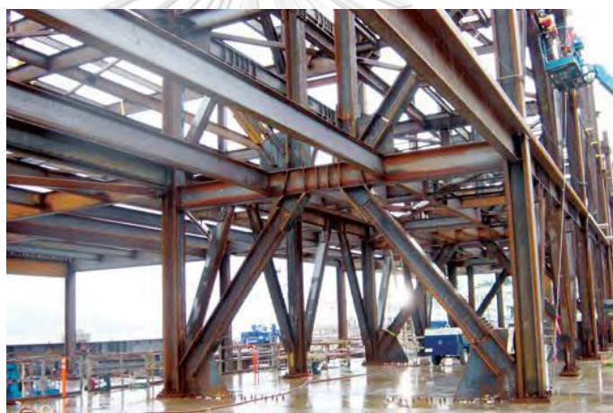
รูปที่ 2.4 อาคารโครงแกนเหล็กแบบเยื้องศูนย์ หรือ eccentrically braced frames
