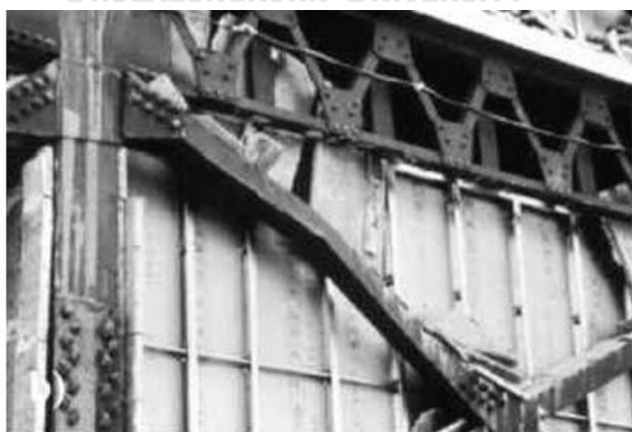
รูปที่ 1.3 การวิบัติแบบโก่งของค้ำยันเหล็ก
