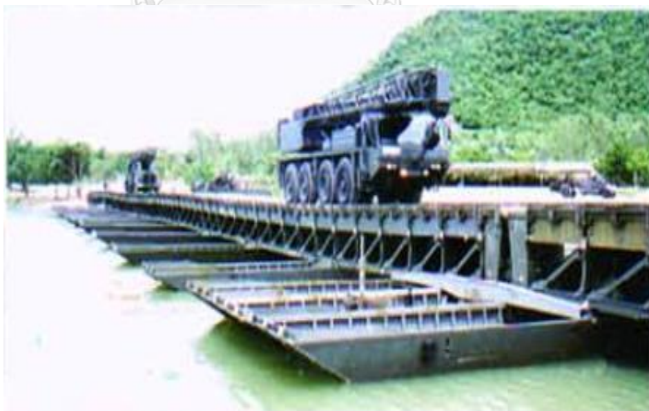
รูปที่ 1 สะพานทหาร เอ็ม จี บี แบบโครงสองชั้นขณะใช้งาน [2]
