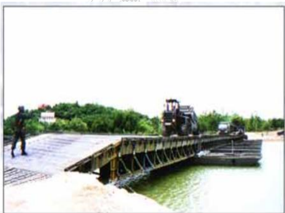
รูปที่ 21 สะพานทหาร เอ็ม จี บี แบบโครงสองชั้นรับน้ำหนักได้สูงสุด 60 ตันยาว 200 เมตร [12]
