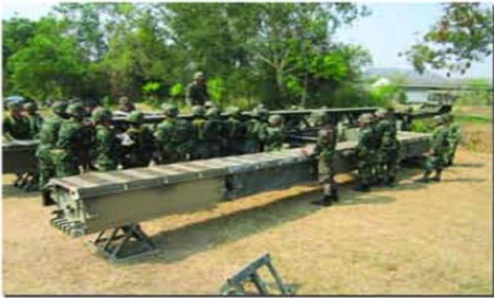
รูปที่ 20 การยกประกอบสะพานทหาร เอ็ม จี บี แบบโครงชั้นเดียว [12]
