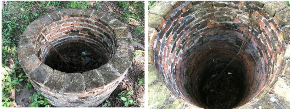
ภาพที่ 63 บ่อกรุ (ซ้าย) และบ่อบาดาล (ขวา)
