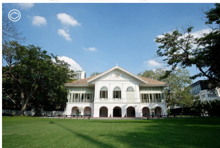
ภาพที่ 71 ส่วนของทำเนียบเอกอัครราชทูตโปรตุเกสประจำประเทศไทยในปัจจุบัน ที่มา: https://readthecloud.co/embassy-4/
