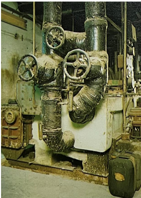
ภาพที่ 5 เครื่องปรับอากาศระบบไอน้ำ เครื่องแรกของประเทศไทย ที่มา : บริษัท เอลิมกรุสมณีนัทสน์ จำกัด, ศาลาเฉลิมกรุง, 2537, 124
