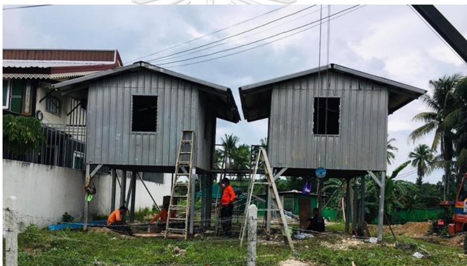
ภาพที่ 25 ศูนย์พักพิงชั่วคราวประเภทบ้านพักอาศัยชั่วคราว (บ้านน็อคดาวน์)
