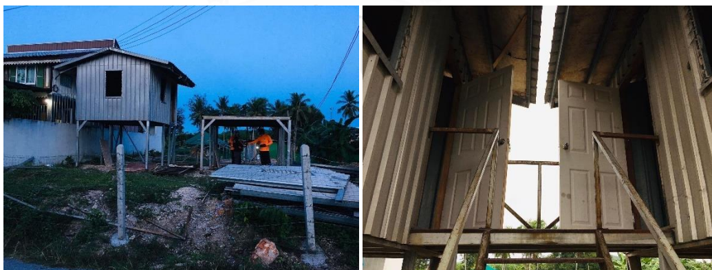
ภาพที่ 31 การติดตั้งบ้านน็อคดาวน
