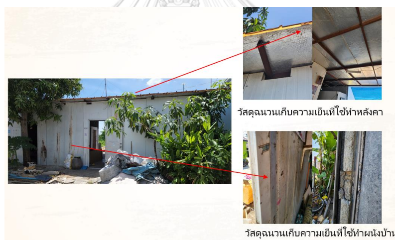
ภาพที่ 5-74 แสดงวัสดุที่ใช้สร้างบ้านแปลงที่ 258-259
