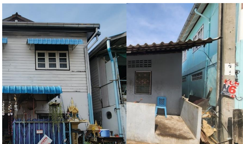
ภาพที่ 5-77 ภาพแสดงตัวอย่างการสร้างบ้านแบบเว้นระยะน้อยกว่า 0.50 เมตร
