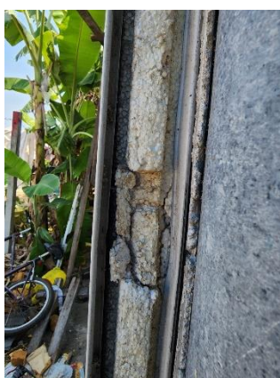
ภาพที่ 5-68 แสดงวัสดุที่ใช้ก่อสร้างบ้านแปลงที่ 258-259
