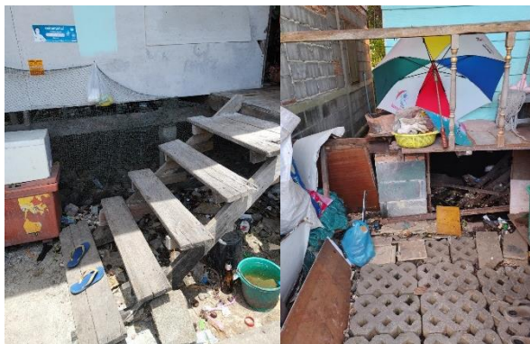
ภาพที่ 4-6 พื้นที่ใต้ถุนบ้านที่ถูกสร้างแบบยกพื้นสูง
