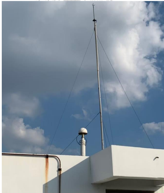
รูปที่ 71 ภาพถ่ายพื้นที่จริงของสถานี PKKT บริเวณสำนักงานที่ดินจังหวัดนนทบุรี สาขาปากเกร็ด
