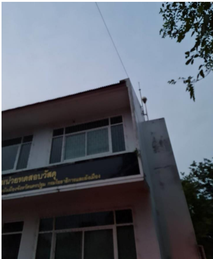
รูปที่ 80 ภาพถ่ายพื้นที่จริงของสถานี NKPT บริเวณสำนักงานโยธาธิการและผังเมืองจังหวัดนครปฐม
