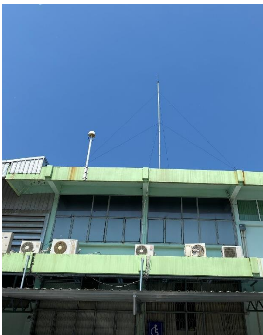
รูปที่ 67 ภาพถ่ายพื้นที่จริงของสถานี BPLE บริเวณสำนักงานที่ดินจังหวัดสมุทรปราการ สาขาบางพลี
