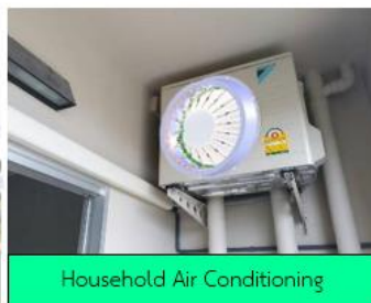
รูปที่ 5.6 ลักษณะการติดตั้งกังหันลมแกนนอนแบบไร้เพลลาเข้ากับอุปกรณ์ต้นกำเนิดลมระบาย
