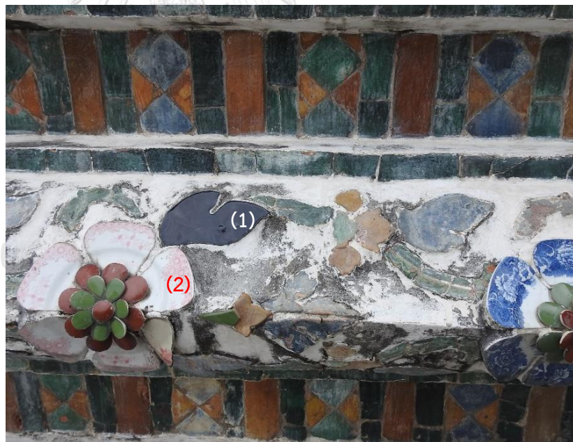
ภาพที่ 3.31 การฝังกระเบื้องเคลือบ (1) กระเบื้องเคลือบชิ้นสำเร็จรูปสีเดียว และ (2) ภาพขณะกระเบื้องเคลือบฝัง ในผิวปูน ตำแหน่งบัวลูกแก้วอกไก่ พระปรางค์วัดอรุณา ที่มา: ผู้วิจัย (2566)
