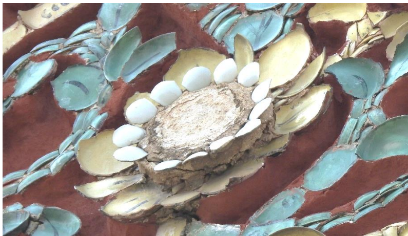
ภาพที่ 3.45 ภาพนูนกระเบื้องเคลือบประดับเป็นรูปดอกไม้หลุดออก
