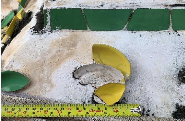
ภาพที่ 3.48 ชั้นภายในกระเบื้องเคลือบประดับพระปราสาทวัดราชบูรณะ หลุดร่วง ที่มา: ผู้วิจัย (2566)
