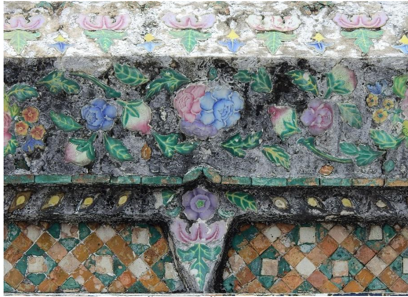
ภาพที่ 3.30 การฝังกระเบื้องเคลือบชิ้นสำเร็จรูปหลายสี บริเวณแข่งสิงห์ เจดีย์รายวัดอรุณา ที่มา: ผู้วิจัย (2566)
