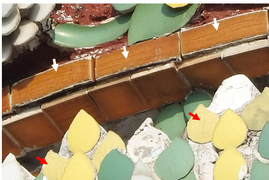
ภาพที่ 3.52 ผิวกระเบื้องเคลือบแตกร้าว ยอดซุ้มประตูทางเข้าวัดอรุณา ทิมา: ผู้วิจัย (2566)
