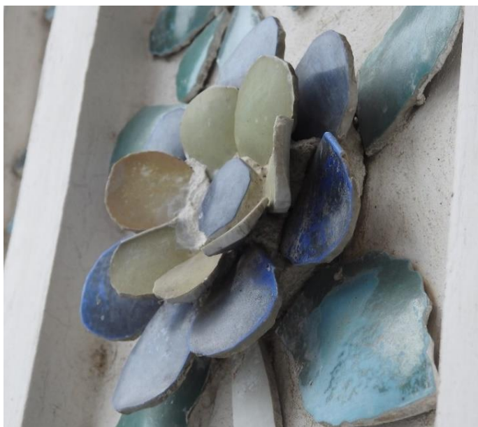
ภาพที่ 3.10 บริเวณขอบภาชนะกระเบื้องเคลือบที่ถูกตัดขลิบแสดงลักษณะเนื้อดินและเนื้อเคลือบที่แนวเสาพระวิหารวัดอรุณฯ
