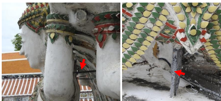
ภาพที่ 3.34 การเสริมแกนโลหะสำหรับประติมากรรมลอยตัวพระปรางค์วิคอรุณา
