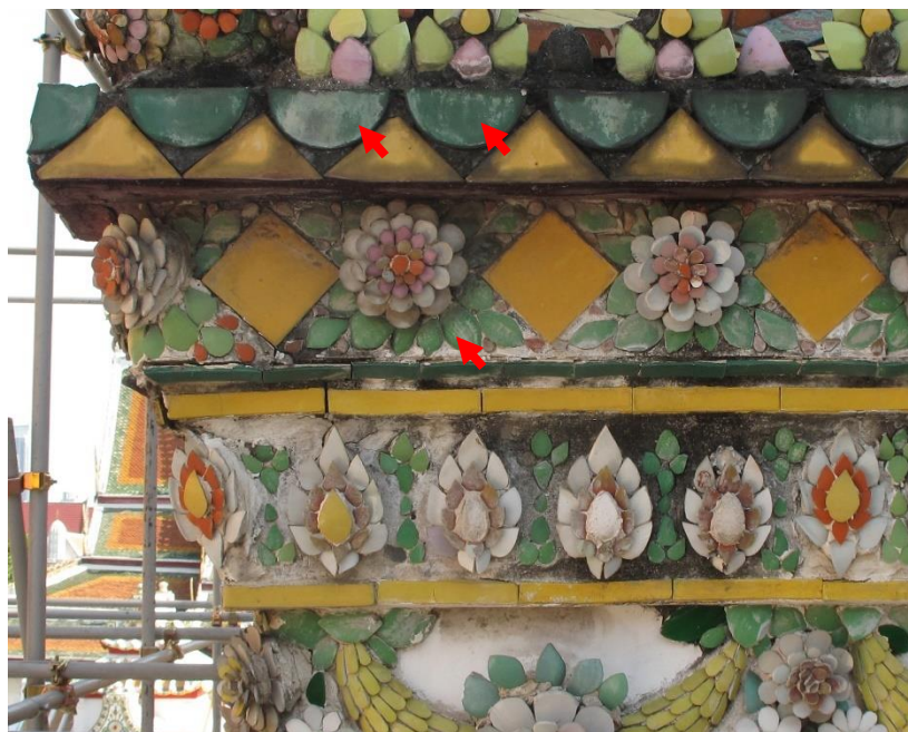
ภาพที่ 3.55 คราบสกปรกที่ผิวกระเบื้องเคลือบ
