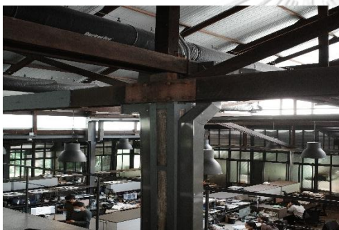
ภาพ 5.54 การใส่เฟืองเสาคานไม้ด้วยโครงเหล็ก
