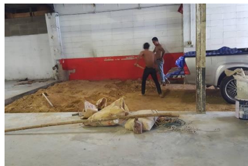
ภาพ 5.59 การก่อสร้างพื้นที่ยกพื้น
