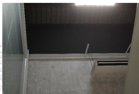
ภาพ 5.15 การติดตั้งเครื่องปรับอากาศ
