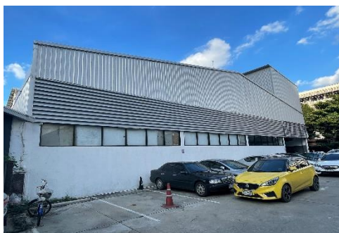
ภาพ 4.53 อาคารสร้างใหม่บนพื้นที่โกดัง S9
