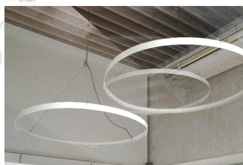
ภาพ 5.17 การติดตั้งดวงโคมห้อยจากโครงสร้างอาคาร
