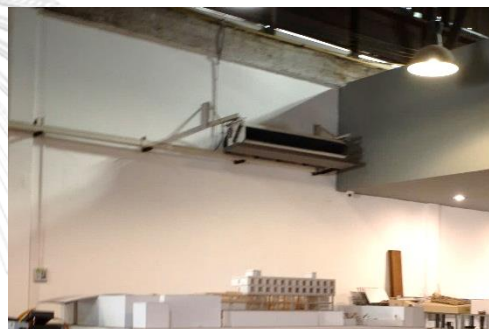
ภาพ 5.26 การติดตั้งเครื่องปรับอากาศภายในสำนักงาน
