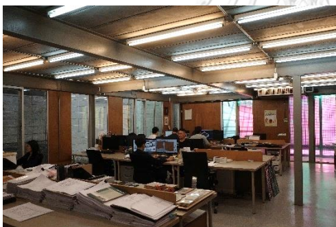
ภาพ 5.40 การติดตั้งระบบแสงสว่างโดยผสมค่าความสว่างของสีไฟ ระหว่าง 4500K และ 6500K
