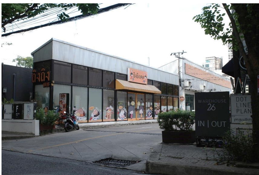
ภาพ 4.33 พื้นที่ร้านค้าสร้างใหม่ในตำแหน่ง R6 เมื่อมองจากด้านหน้าทางเข้าโครงการ
