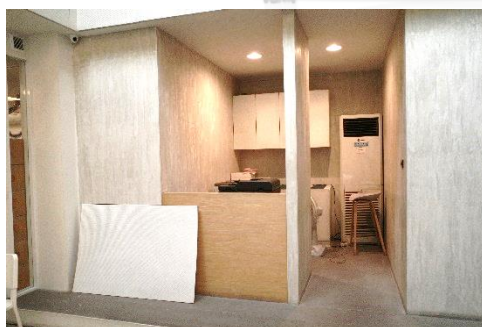
ภาพ 5.16 การติดตั้งดวงโคมบนฝ้าภายในพื้นที่โครงการ
