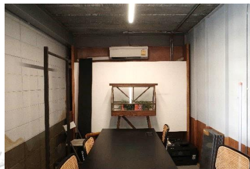
ภาพ 5.39 การติดตั้งเครื่องปรับอากาศภายในพื้นที่ปิด
