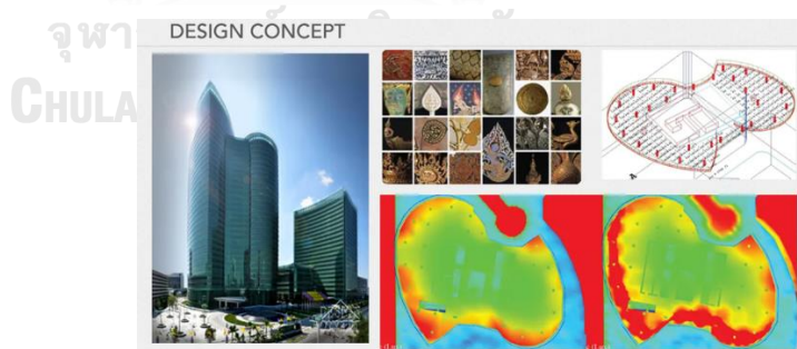
ภาพที่ 13 อาคารศูนย์เอนเนอร์ยีคอมเพล็กซ์ (Energy Complex : ENCO)
