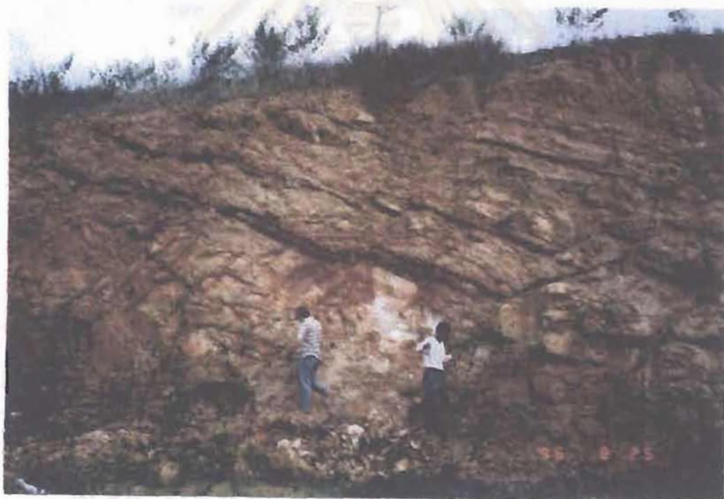
รูป 5.10 รูปบน ลักษณะรอยเลื่อนที่ตัดผ่านเข้ามาในชั้นดินเบา(diatomite)สีขาวที่แทรกสลับอยู่กับชั้นดินบอแลอซ์(สีน้ำตาลเหมือนเรดินเบา ค.นาคค อ.แม่ทะ จ.ลำปาง) ซึ่งแสดงหน้าเหมืองด้านเหนือและแสดงชั้นหินวางตัวในแนวระดับ รูปล่าง แสดงหน้าเหมืองด้านใต้ซึ่งการวางตัวของชั้นหินมีการเอียงเทไปทางทิศตะวันตก ทั้งสองภาพแสดงลักษณะรอยเลื่อนปกติ(normal fault)ซึ่งตัดผ่านเข้ามาจนถึงดินชั้นบนที่เกิดในสูกปัจจุบัน (Holocene)
