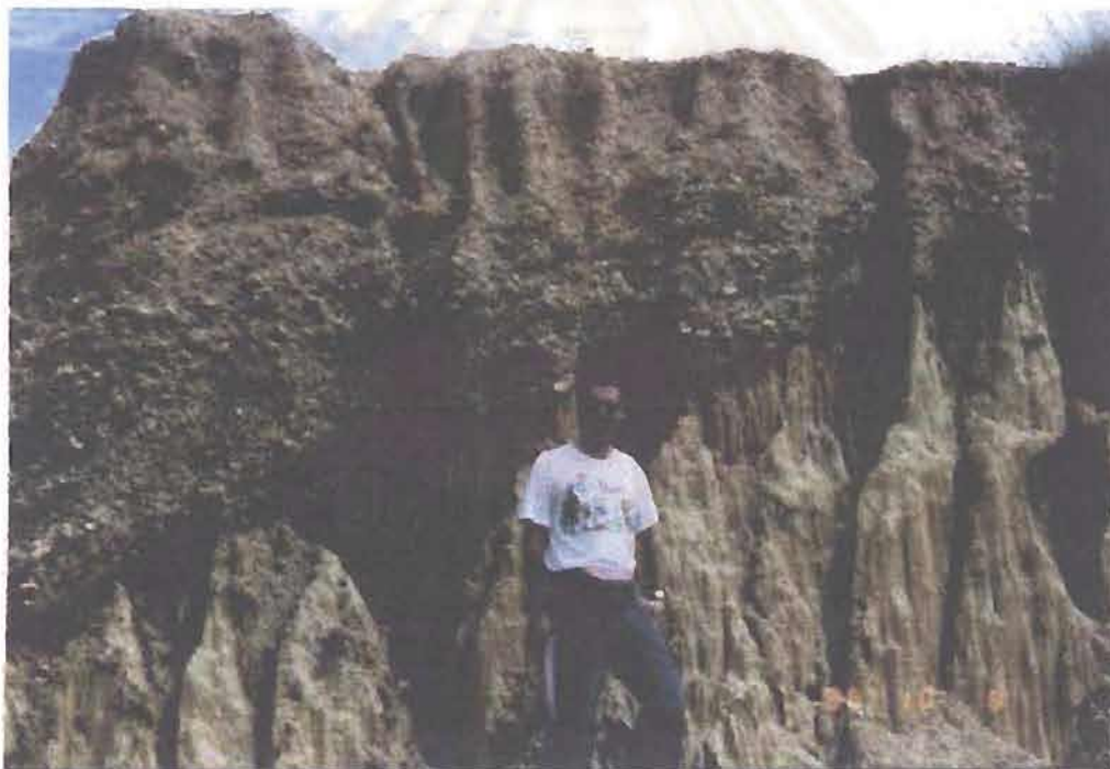
รูป 5.13 รูปเขียน รอยเลื่อนปกติ (normal fault) มุมสูงยุคปัจจุบัน (Quaternary) ที่ตัดเข้ามาในชั้นกรวดและชั้นดินเหนียวปนดินสีเหลืองอมน้ำตาล ทำให้เกิดระยะเลื่อนตัวแนวตั้งประมาณ 2 เมตร เส้นทางสาย ลำปาง-แพร่ (จากแพร่ 30 กม. ทางตะวันตก) รูปถ่าย ลักษณะรอยเลื่อนปกติเกิดขึ้นดังตัดเข้ามาในชั้นกรวดและตะกอนทรายสีเหลืองที่กลางแต่ไม่ตัดเข้ามาในกรวดชั้นบนสุด แอ่งแพร่ อ.เมือง จ.แพร่ (Dr. Clark Fenton ร่วมสำรวจภาคสนาม)
